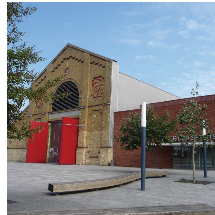
6 La salle des Sports du Grand Large est conçue par l'Atelier Ferret Architecture, en 2009. Le bâtiment à Haute Qualité Environnementale réutilise le fronton des anciens ateliers d'ajustage et s'intègre à la ZAC du Grand Large occupant l'ancien avant-port est.
