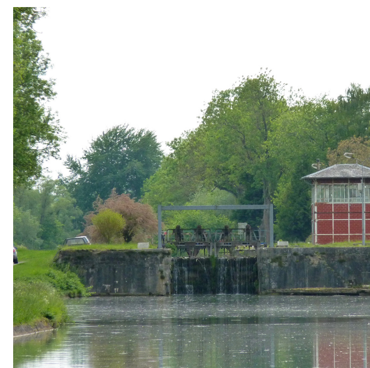
4 Écluse de Vaucelles sur le canal de Saint-Quentin
