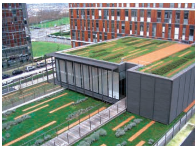
Toit végétalisé ① Ecovégétal
