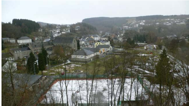
Le cœur d'Houffalize qui bénéficie d'un site paysage remarquable mais qui se démarque par une architecture de valeur très passable : un exemple de paysage moyen
