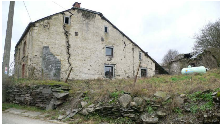
Brisy : un exemple de toiture étalée favorisant de larges pignons. Le faite est « brisé » par des croupettes
