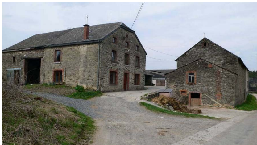
Rettigny : bel enchaînements de volumes, qui animent l'espace public en créant des « usoirs » et des espaces de circulation secondaire entre les bâtiments.
