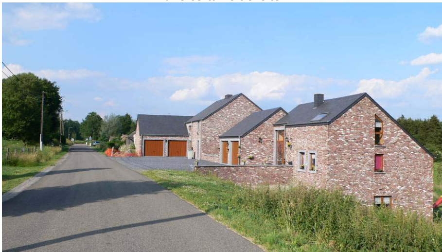
Champs. Architecture de type « intégration » visant à retrouver une certaine densité d'habitat. Dommage que l'utilisation de la brique évoque une identité paysagère plus proche de la Hesbaye namuroise que de l'Ardenne.
