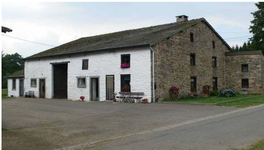
Les Tailles (Houffalize). Très bel habitat traditionnel. A remarquer : la forme talutée et la profondeur du bâtiment. Pente de toiture relativement faible.
