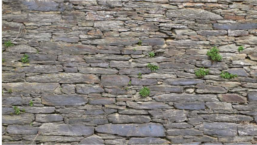
Maçonneries schisteuses typiques de l'Ardenne
