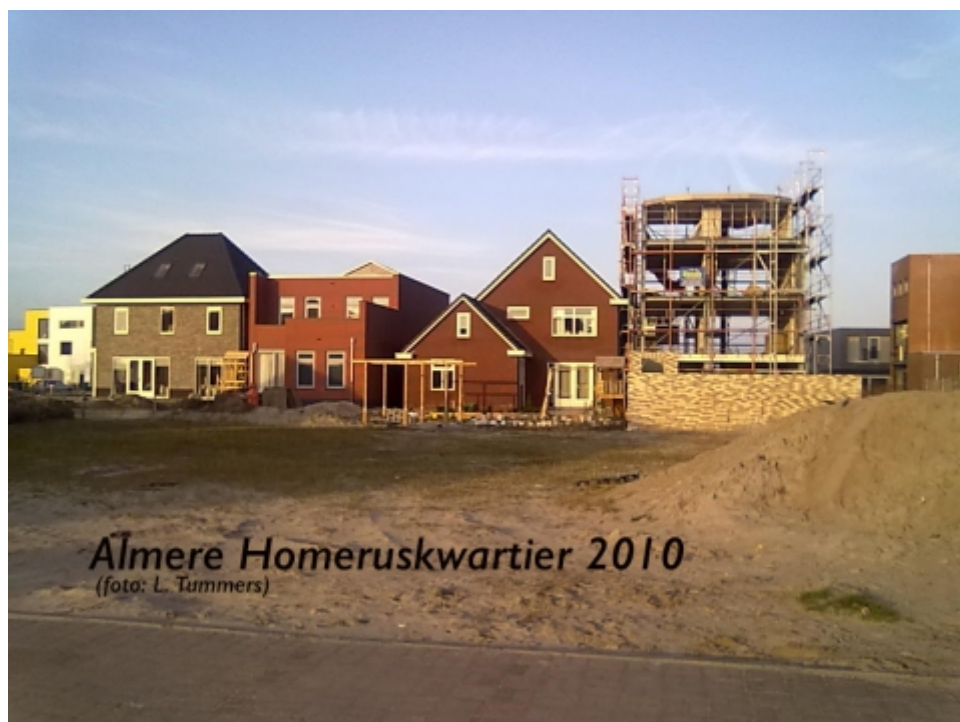
PHOTO 3 : Construction du quartier Homerus à Almere en autopromotion individuelle
