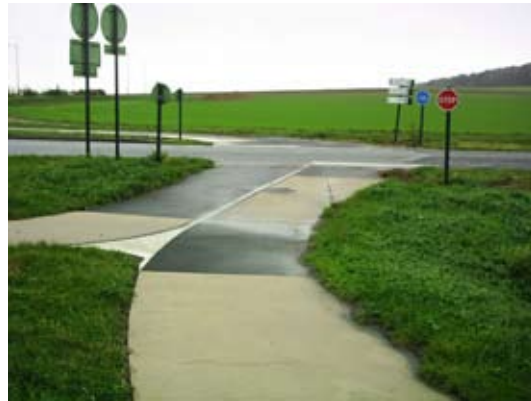
Exemple de traitement d'une intersection sur une piste cyclable bidirectionnelle (Conseil Général du Pas-de-Calais)
