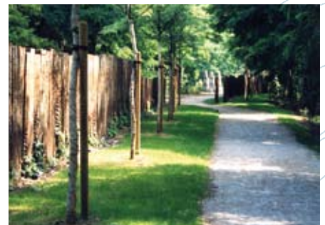
L'usage des traverses de chemin de fer rappelle la vocation première des sites, favorise le recyclage d'un matériau. En jouant sur l'espacement, on peut gérer le niveau de perméabilité souhaité.
