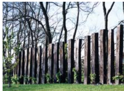
L'usage des traverses de chemin de fer rappelle la vocation première des sites, favorise le recyclage d'un matériau. En jouant sur l'espacement, on peut gérer le niveau de perméabilité souhaité.
