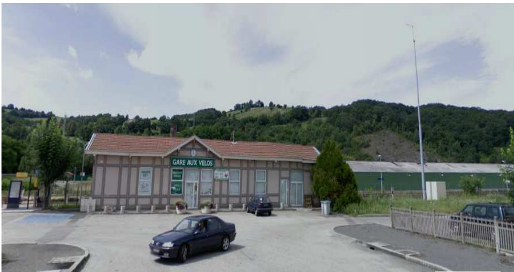
Magasin de cycles en gare de la Fouillouse (42) 75MD/job
