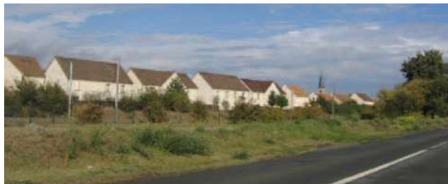
Le caractère inondable de la plaine inondable contraint fortement son urbanisation. A Bruyère-sur-Oise, la voie ferrée marque la limite des extensions urbaines vers l'Oise.
