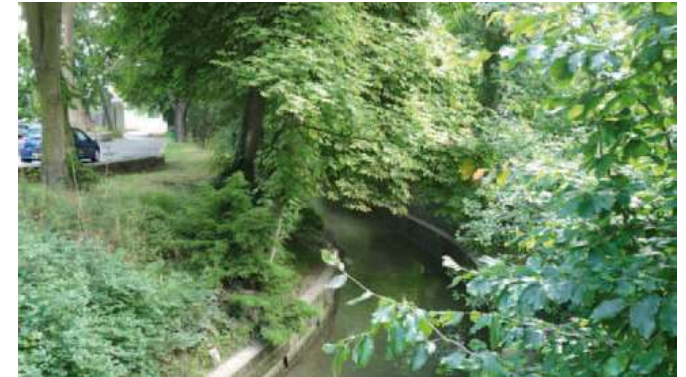
La trame verte de fond de vallon n'est pas comprise comme un élément fondateur de la structure urbaine. Le Croult, dans l'espace urbain est en situation reléguée et peu visible. Dans les différents maillons verts qu'il traverse, il n'est pas possible de suivre son cours.
