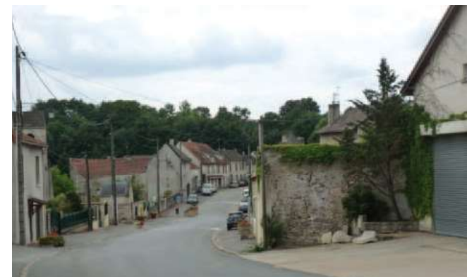
Vaudherland situé en fond de vallon est comme hors du temps. En contrebas de la RD 317, il est presque invisible depuis les infrastructures. Il semble exclu du rapport avec le plateau et de ses dynamiques de développement. Le village permet pourtant un accès à la zone d'activités du Thillay mais ne permet plus de relier Roissy-en-France par le fond du vallon.
