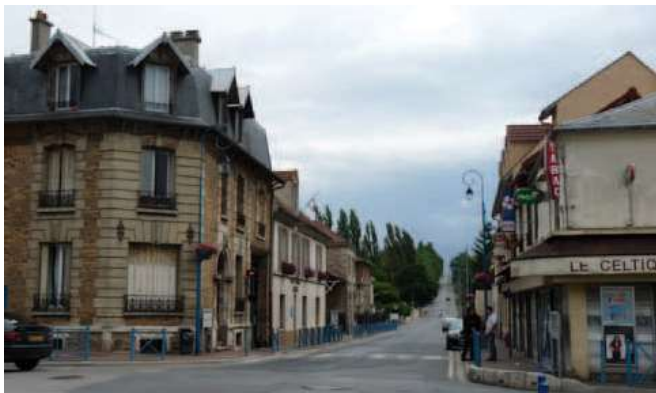
La rue des Ecoles, au Thillay, permet de prendre la mesure du caractère encaissé des villages anciens dans le vallon du Croult. Derrière les peupliers, sur le plateau, la zone d'activités s'est développée contre la RD 317.
