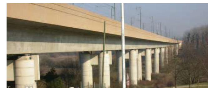
La LGV franchit le Rhin à Goussainville, par un superbe viaduc sous lequel peuvent aisément passer le paysage du vallon et les promenades qui pourraient l'accompagner.
