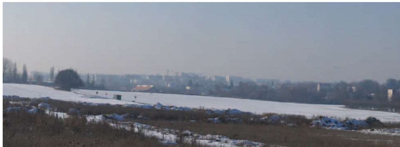
Le tracé serpentin du Croult dessine la limite départementale à l'est. L'urbanisation s'arrête à la vallée qui la contient mais la ville n'entretient pas de contact avec l'élément de nature sur lequel elle s'appuie. Cette limite, constituée d'arrières de parcelles est identifiable comme un confins. Au-delà, l'échelonnement des paysages urbains s'étend de manière indistincte jusqu'à l'horizon. Seules les silhouettes des grandes cités constituent des repères qui permettent de localiser les différentes unités habitées. À hauteur de Gonesse, l'espace naturel du Croult se cache.
