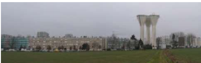
Le front bâti de Villiers-le-Bel et Arnouville-lès-Gonesse est en contact direct avec la plaine. Hormis la radicalité des façades, la limite n'est pas assumée. Stationnements, poste électrique, chauffage urbain ou châteaux d'eau prennent place sur la ligne entre ville et campagne.
