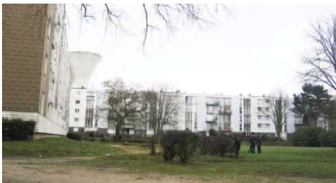
Pieds d'immeubles à Arnoville-lès-Gonesse Le surdimensionnement des espaces semi-publics de coeur de cités est manifeste. Leur maintenance impose un coût de gestion non négligeable qui pèse sur les habitants. Ils renvoient généralement une impression de vétusté, voire de déshérence tant l'espace est peu pratiqué, peu emprunté. Le pied d'immeuble en premier plan est constitué de caves, le rez-de-chaussée est donc aveugle, ce qui est une situation très courante. L'espace extérieur est ainsi en situation arrière. Le pied d'immeuble en second plan est un espace « résidentialisé » de manière spontanée par les habitants avec trois bouts de cagettes qui cherchent à protéger de l'espace central. L'idée d'espace naturel est fugitive malgré une présence arborée de belle ampleur.
