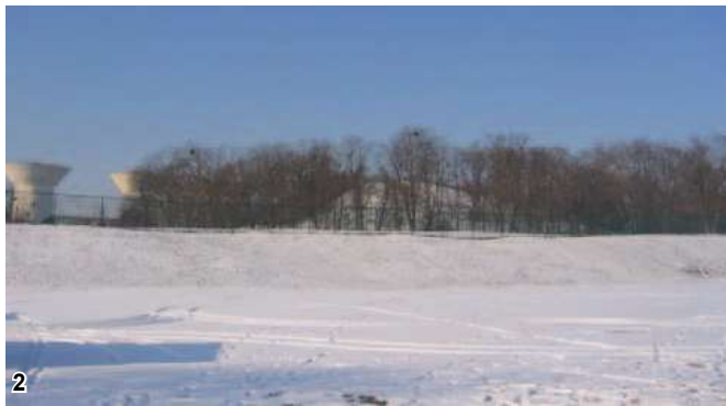
2 Le fort de Stains est un espace public en situation retranchée. Ses abords n'indiquent en rien sa présence.
