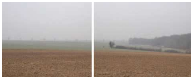
Les plantations d'alignement qui accompagnent la RD 14 jouent un rôle paysager en soulignant la direction générale qui commande l'infrastructure, fondée sur la géographie du plateau.
