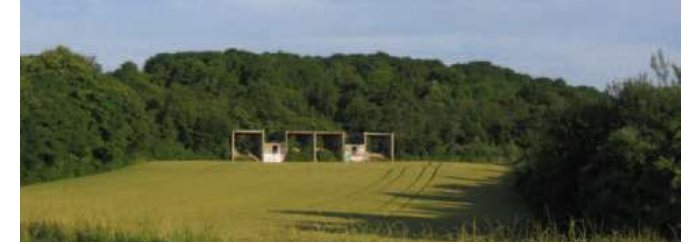
Les extrémités des vallons sont souvent des portions de paysages partagés entre deux unités. Sans attributions, ils sont de ce fait particulièrement fragiles. Ici, entre le vallon du ru de Montubois, du ru de Chauvry et la vallée de la Seine, une construction en ruine entre les champs et les boisements.
