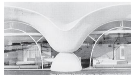
UNE DÉMOLITION EXEMPLAIRE Magasin de meubles Transit, Bellegarde-sur-Valserine. Jean-Louis Chanéac, architecte - 1971
