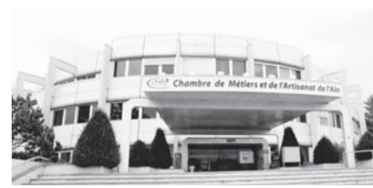
GLISSEMENTS D'APPARENCE ET D'ESPACES Banque régionale de l'Ain, Bourg-en-Bresse Cropier architecte - 1973
