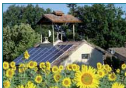
Montéléger - Utilisation d'énergies renouvelables : éolienne et panneau solaire (photo PIE Adil 26)
