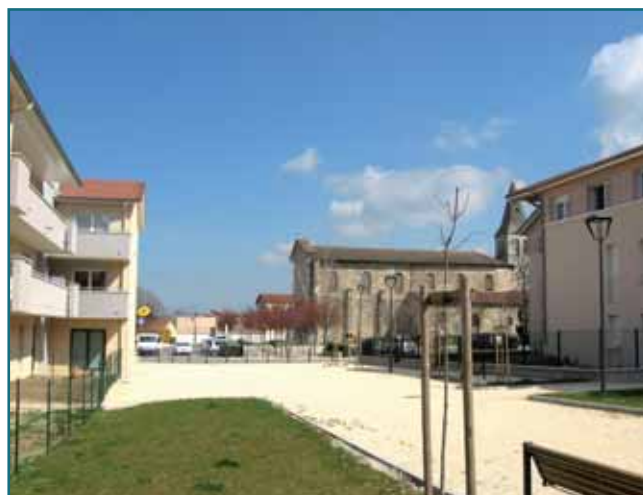
Hostun - un quartier nouveau en greffe avec le village (photo Caue)
