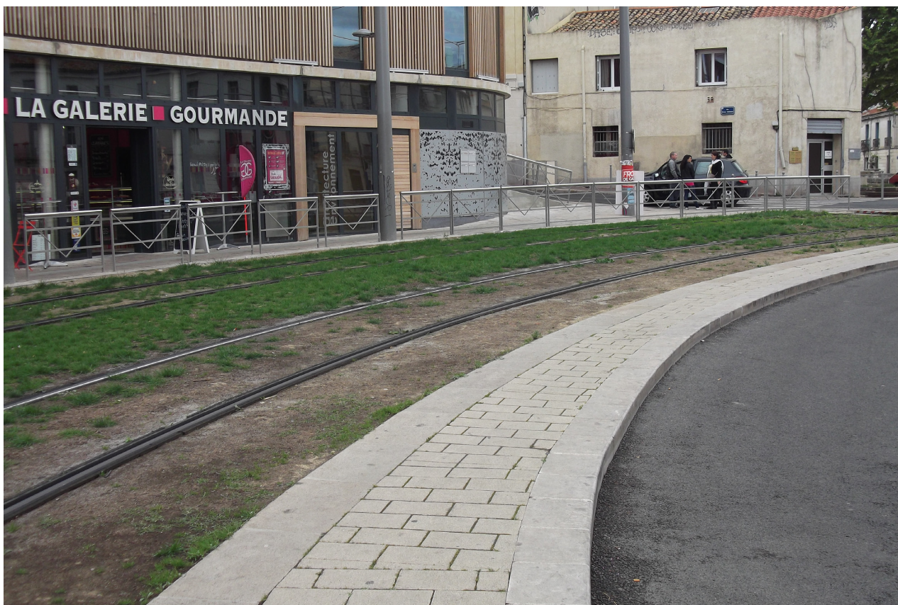
Figure 8 - Lignes végétalisées du tramway à Montpellier, la partie ombragée a partiellement résisté à la sécheresse Source: Auteur (20/07/2012).
