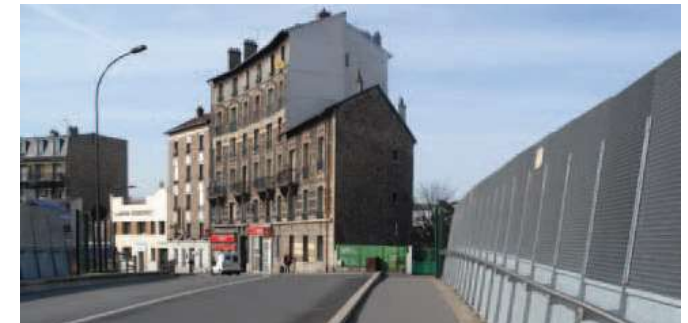
Le passage des voies ferrées dans les villes anciennes a engagé un certain essor tout en provoquant d'énormes fractures et stigmates à gommer, tels les pignons aveugles de ces immeubles de rapport. La qualité des franchissements conditionne l'ambiance des paysages urbains et leur confort d'usage.
