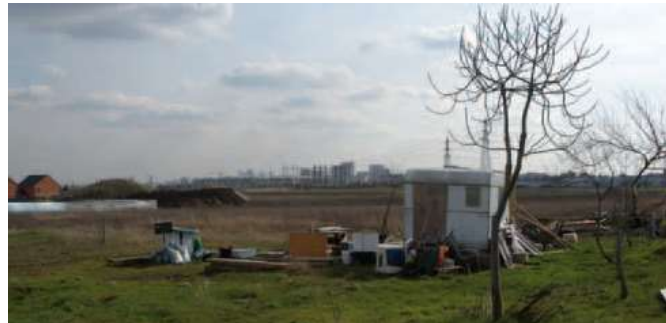
Le transformateur électrique (en arrière plan) dans la partie centrale de la plaine stigmatise ces ouvertures agricoles pourtant nécessaires à la compréhension de la structure du site.
