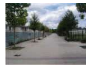
L'allée verte réalisée dessert l'îlot de constructions neuves de promotion privée.
