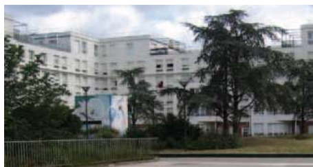
Réhabilitation antérieure à la présente phase de projet intégrant l'adjonction d'un étage, loggias et redans en façade.
