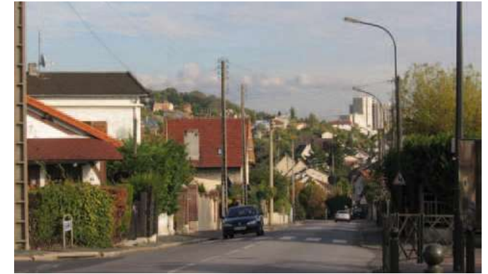
Investissement du coteau des buttes du Paris par un tissu urbain hétéroclite allant du colossal habitat collectif, au pavillonnaire hétérogène.
