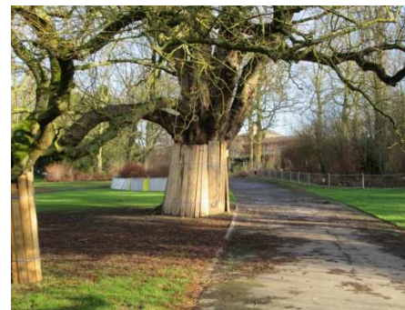
Figure 17 - Protection des arbres dans le périmètre chantier - Parc Barbieux
