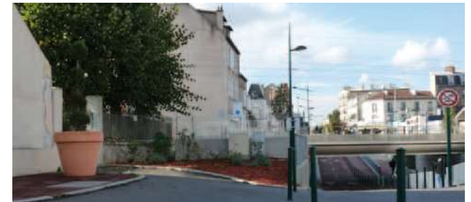
Passage de la RD 14 en souterrain pour préserver le centre ville piétonnier de Sannois. Le passage de la voie ferrée génère des ouvrages de franchissement de grande envergure. Il introduit un vocabulaire routier en ville. Malgré le passage fonctionnelle, la structure urbaine de la RD14 n'est plus efficiente.
