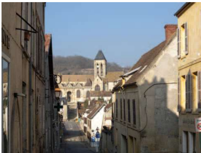
Perspective cadrée par les façades. Le relief révèle la structure de paysage urbain, en lien avec le rebord des coteaux de Seine qui en forme l'horizon. Une position « stratégique » de l'église sur sa charpente naturelle, magnifiée par la lumière rasante du soir.
