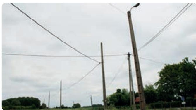
Début juin, ERDF a entrepris la rénovation du réseau électrique sur une partie de la rue du Pontceau. Sur une distance de 500 m, du secteur des Etangs jusqu'à l'intersection de la rue de Warnetion, les techniciens ont remplacé l'ancien câble par un câble torsadé en aluminium qui permettra d'améliorer sensiblement la qualité d'alimentation électrique.
