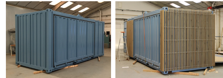
Fabrication des éléments chez le prestataire, visites régulières et suivi des adaptations et mises au point diverses.
