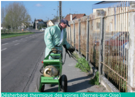
Désherbage thermique des voiries (Bernes-sur-Oise)
