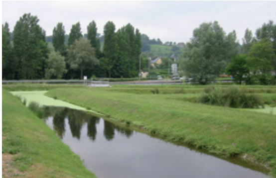
Jardin filtrant améliorant la qualité du rejet de station d'épuration dans le milieu naturel - Honfleur (14)
