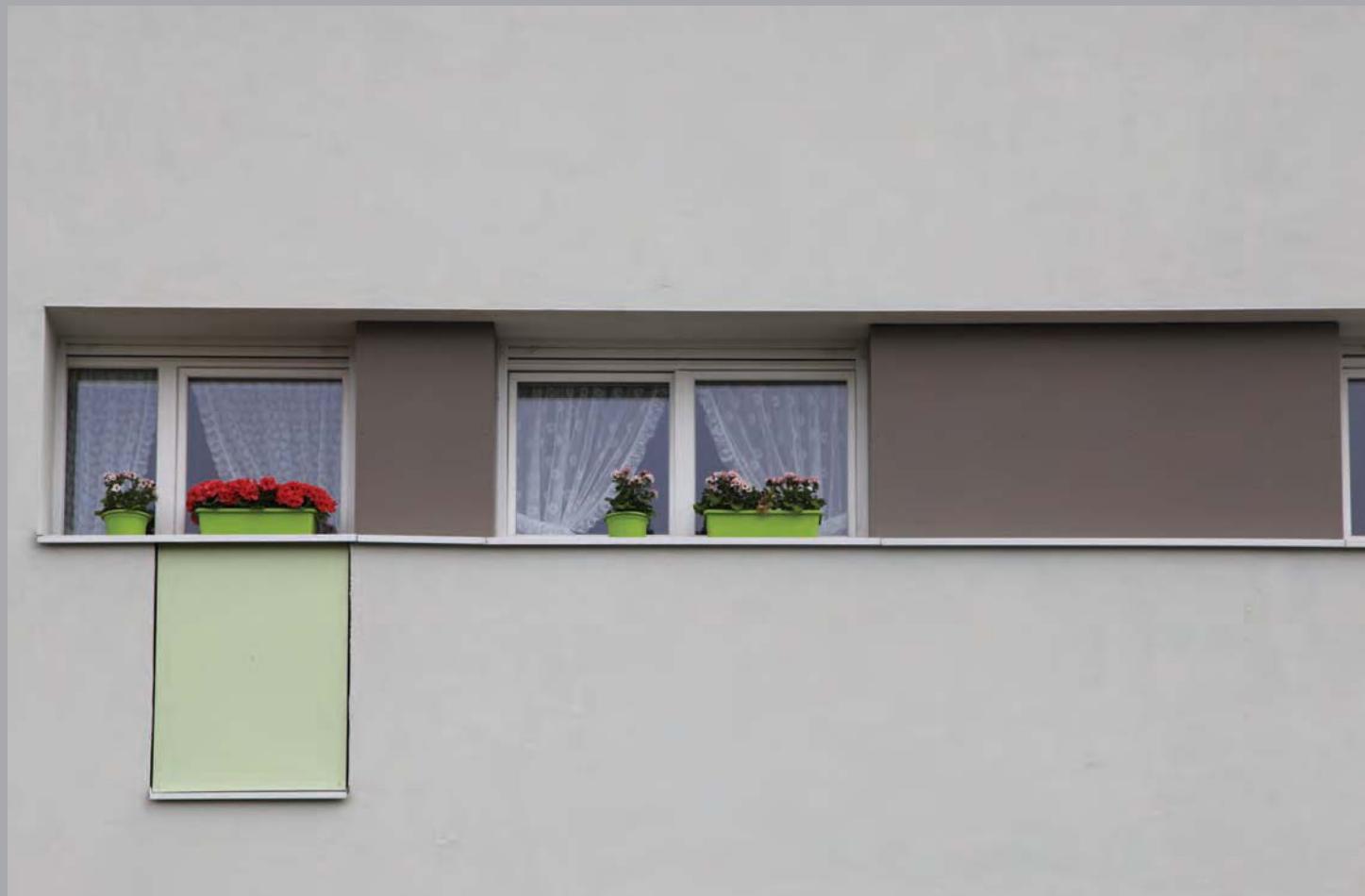
Détail façade sur rue J.B Corot
