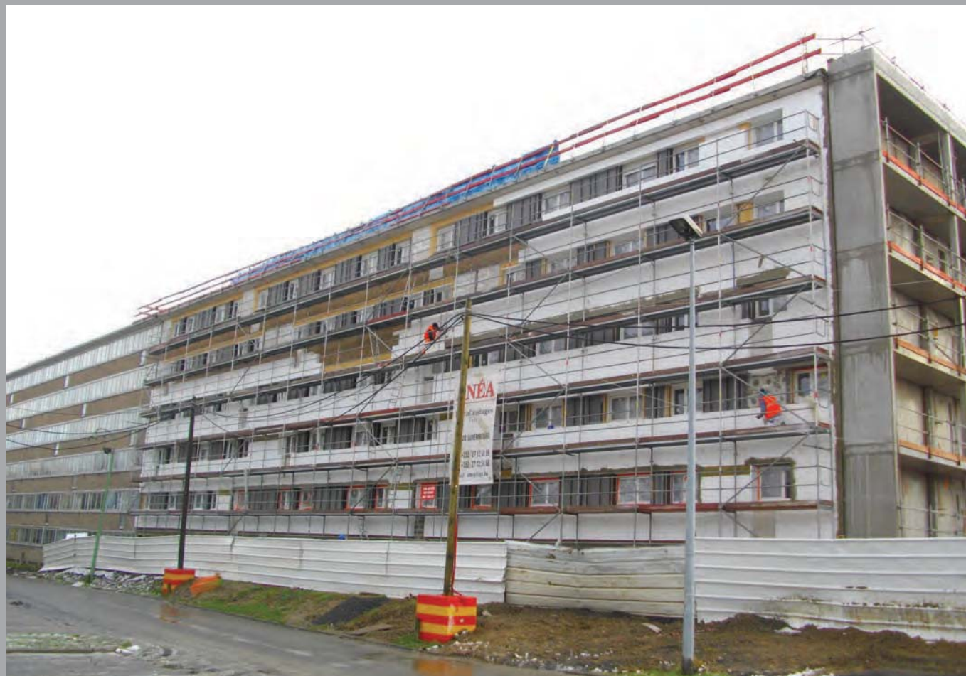
Vue des travaux depuis la rue J.B Corot
