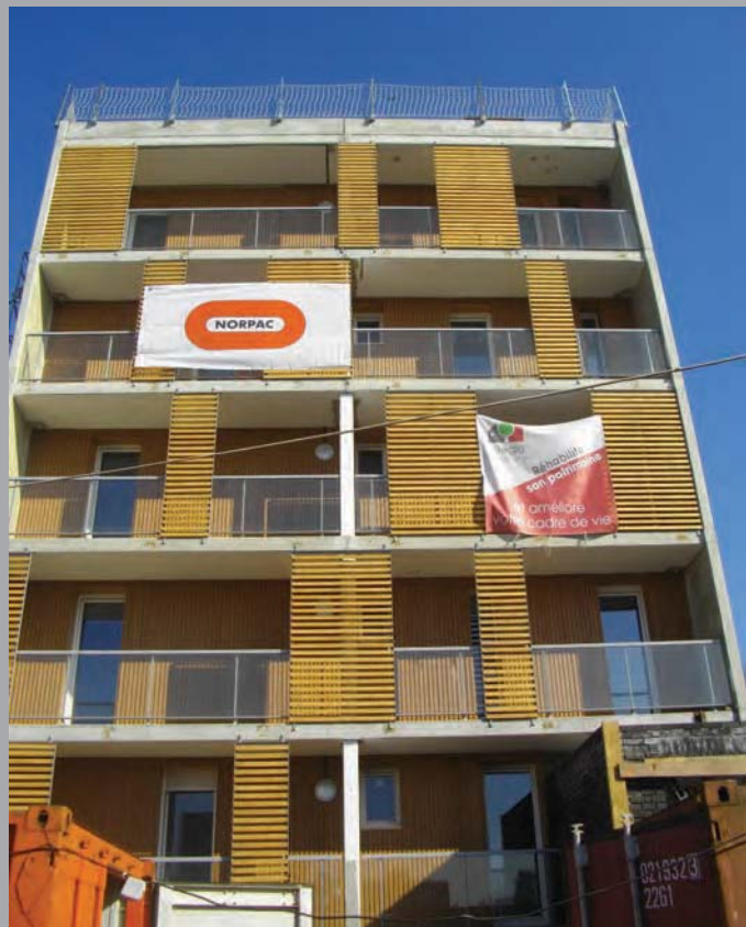
Travaux du pignon 2/3
