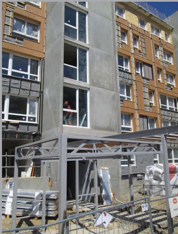
Pose des bardages bois
