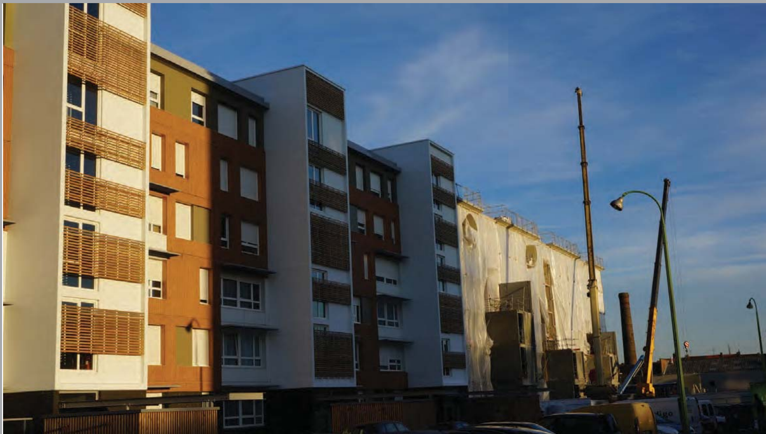
Bâchage de la troisième tranche travaux
