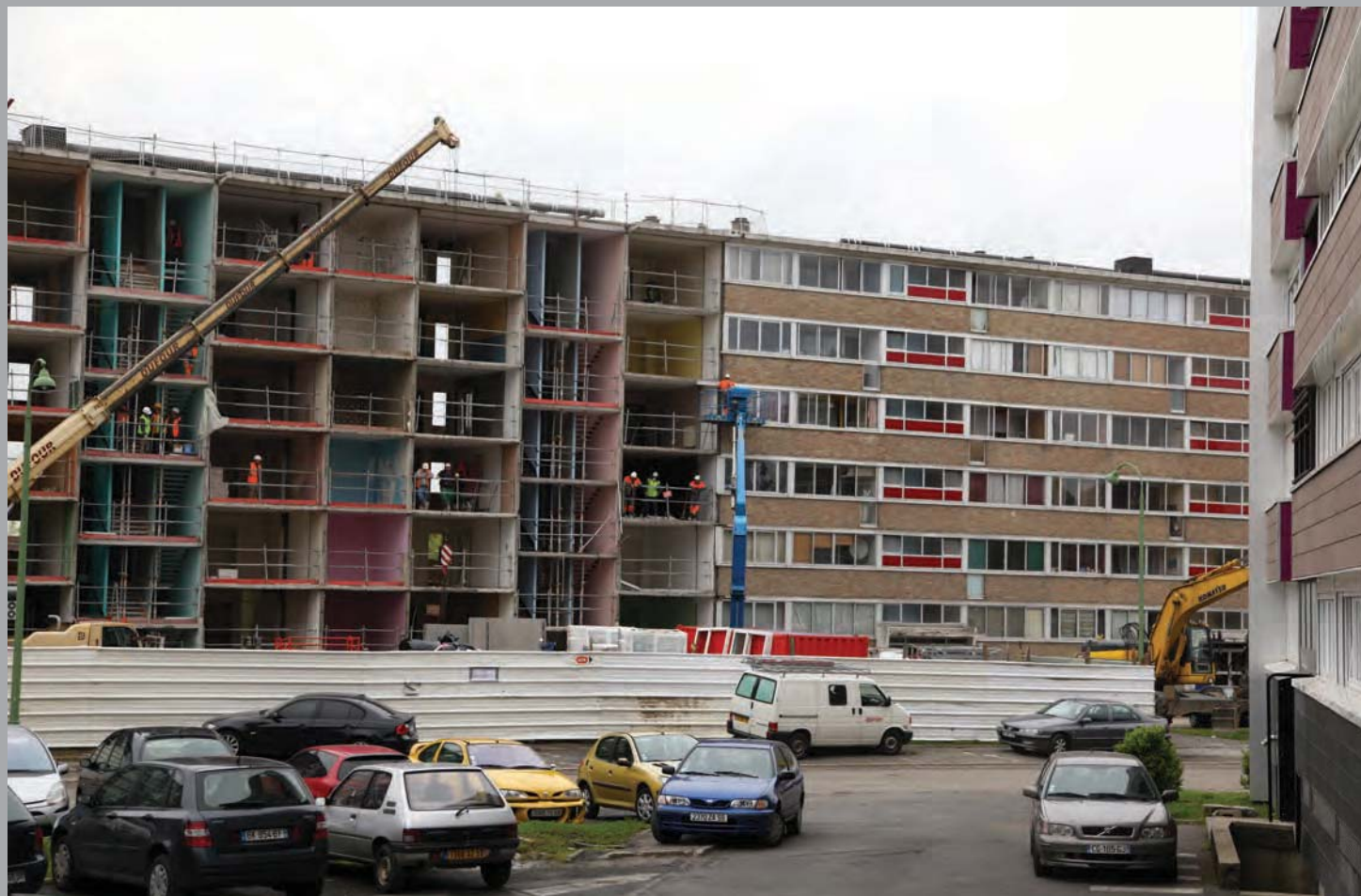
Curage de la deuxième tranche
