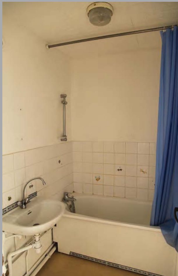
Salle de bain avant / après requalification
