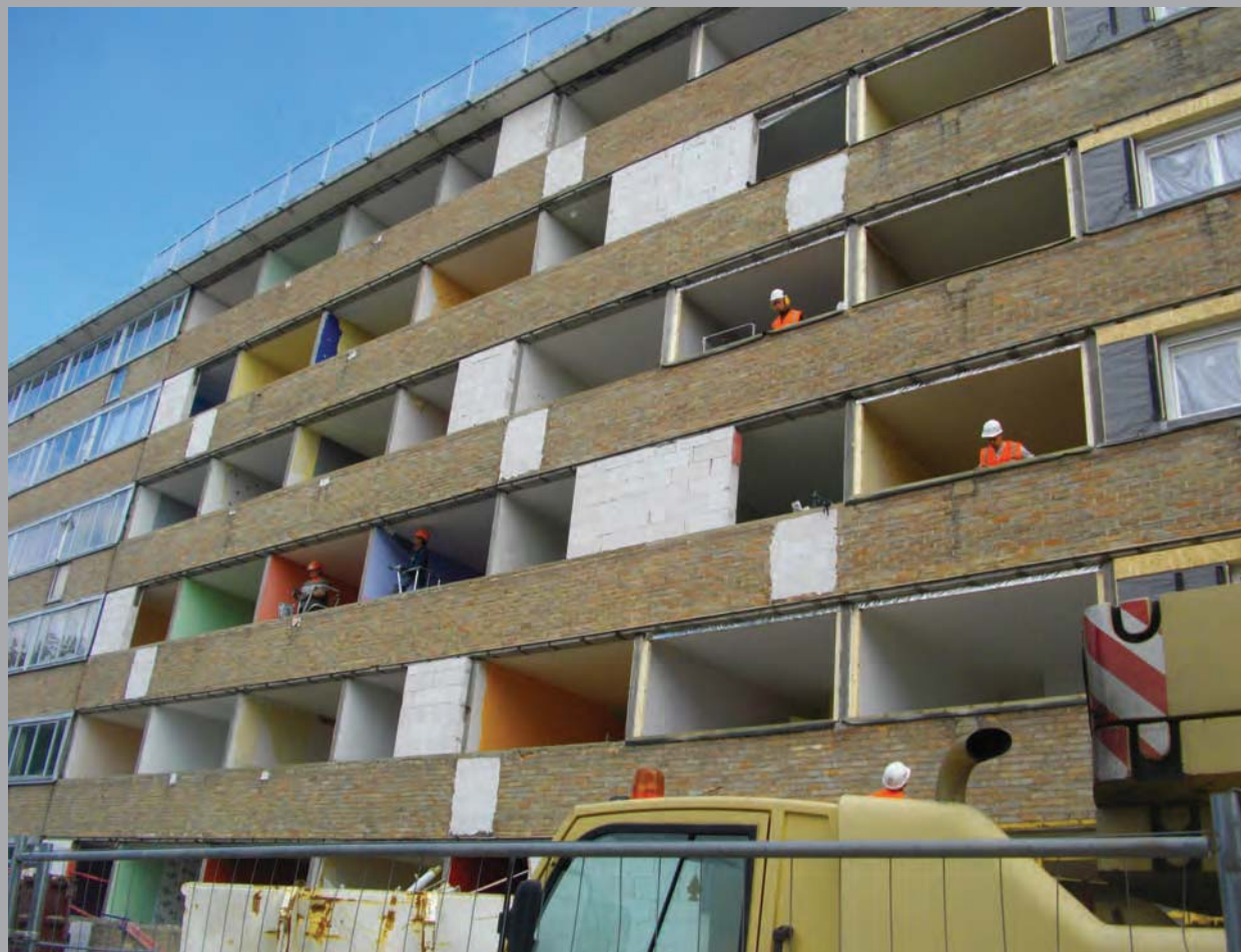
Réalisation de la maçonnerie sur rue J.B Corot avant pose des façades
