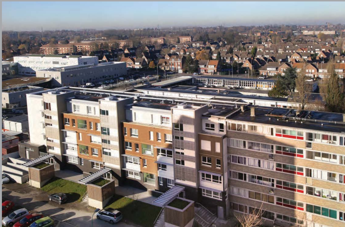
Première tranche requalifiée - vue d'ensemble
