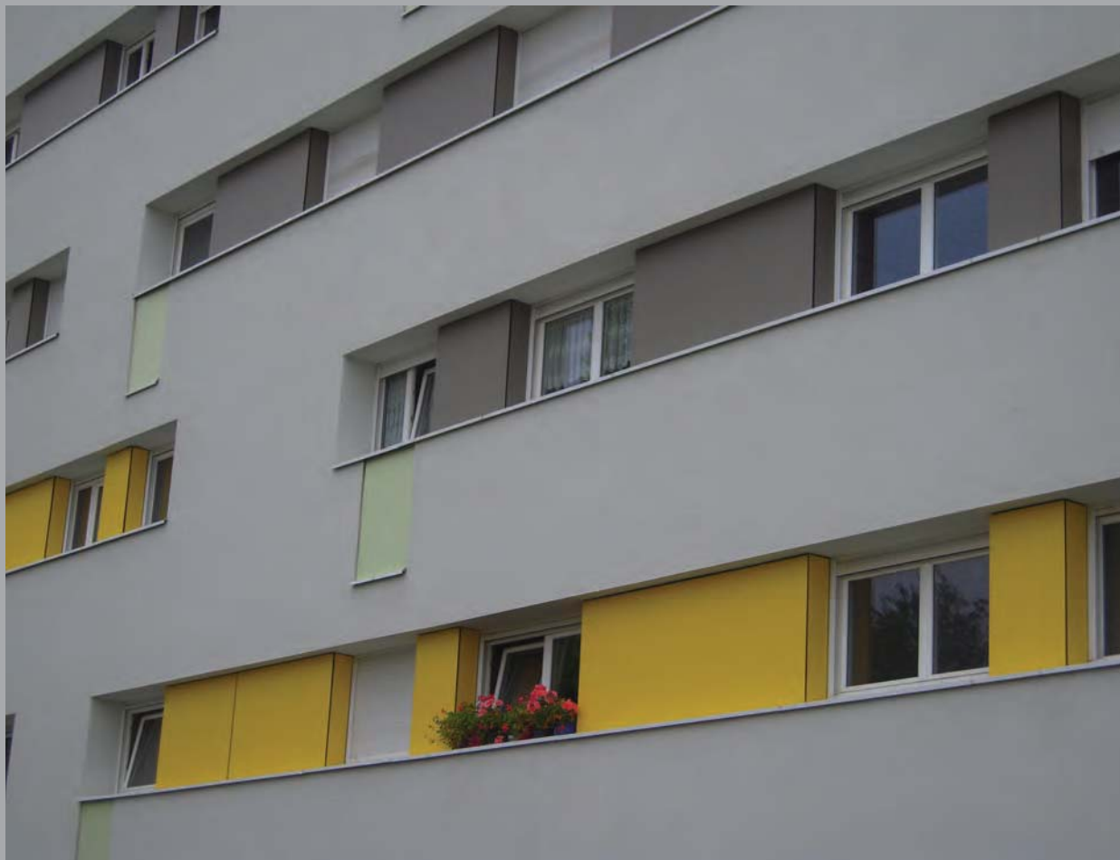
Vue sur la façade Euclide 1 depuis la rue J.B Corot
