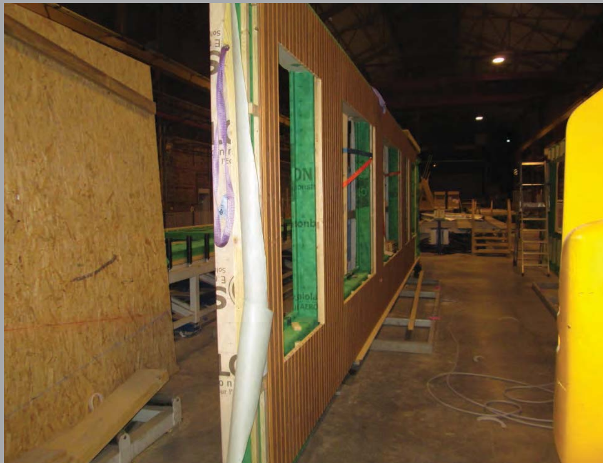
Les éléments de bardage utilisés pour la troisième tranche travaux
