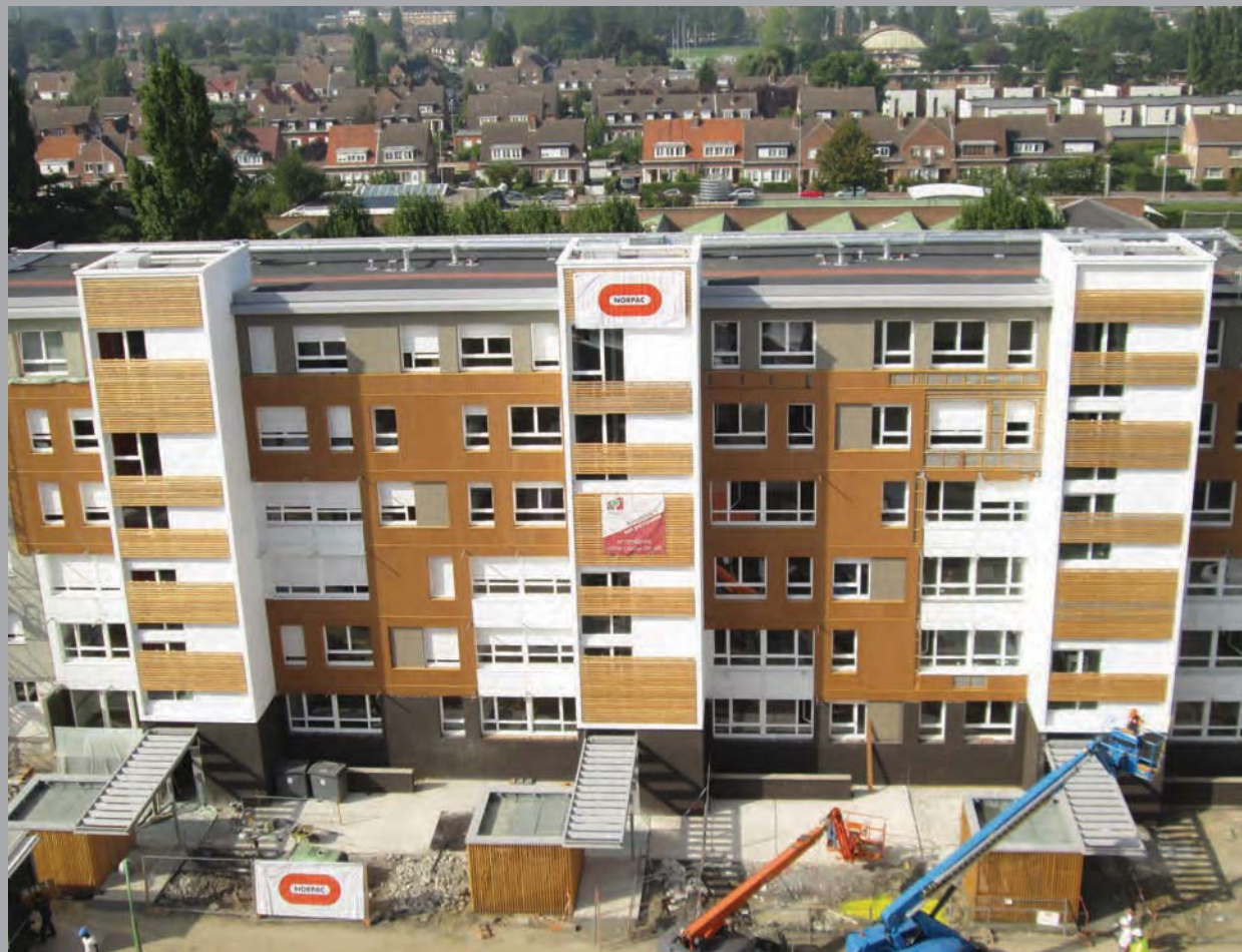
Deuxième tranche requalifiée - vues de détail et d'ensemble depuis l'avenue J.F Kennedy
