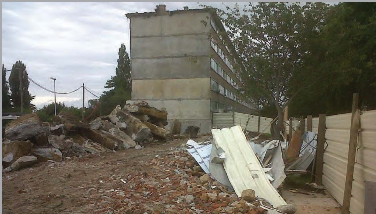
Démolition de la travée à l'extrémité de la barre
