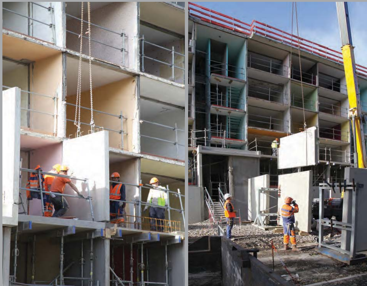
Pose des pré-murs et planchers pour les extensions.
