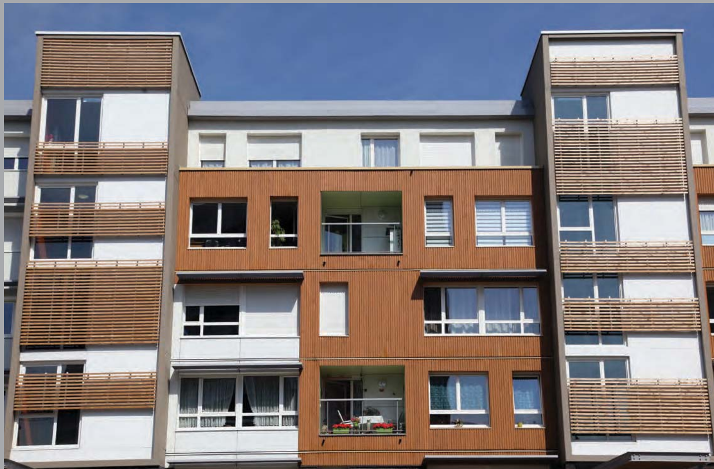
Détail façade sur l'avenue J.F Kennedy
