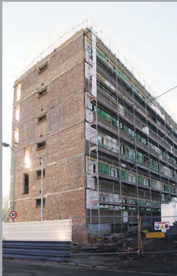
Vues sur le pignon rue H. Matisse et sur la façade sur rue J.B Corot
