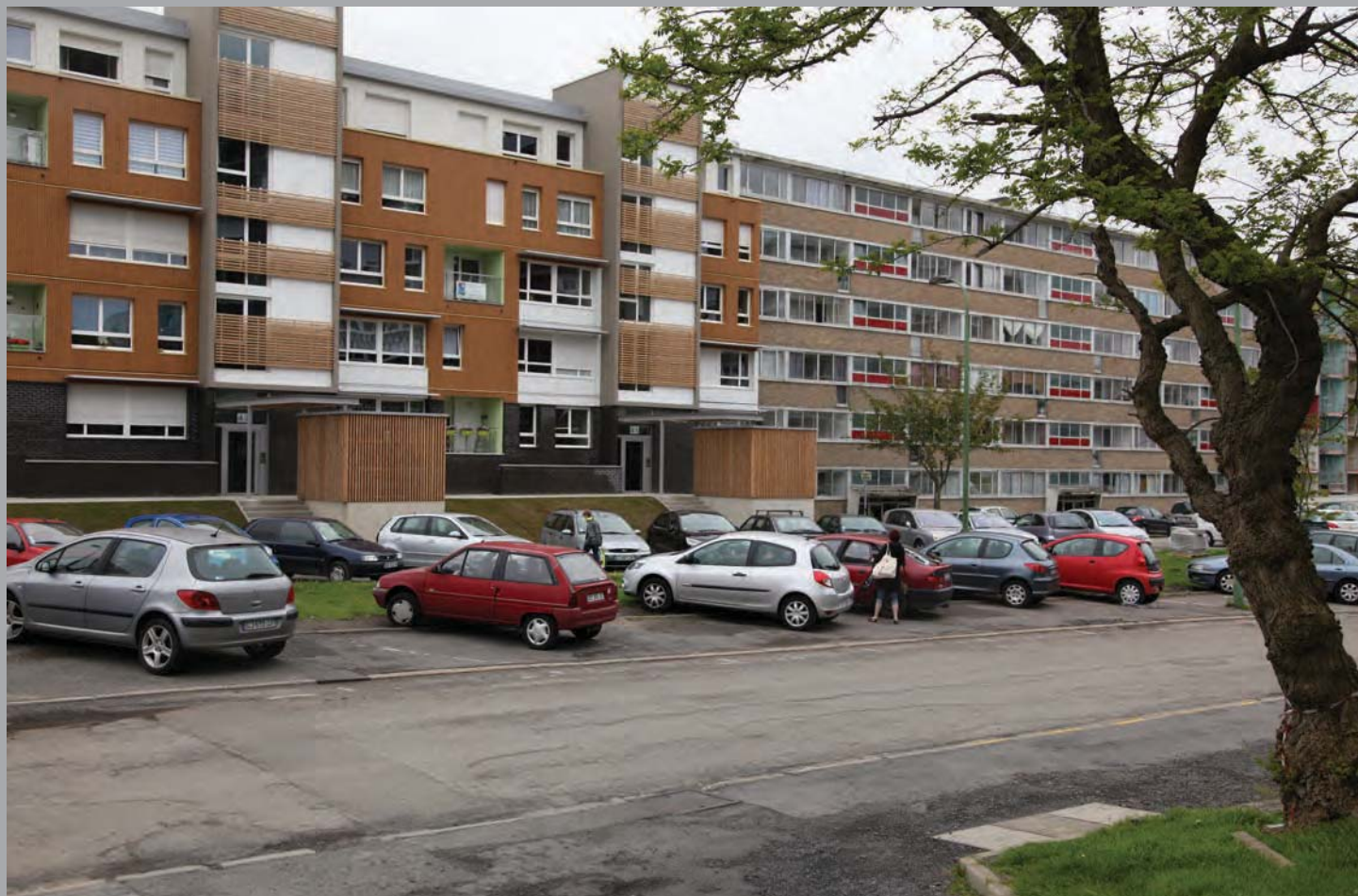
Vue sur Euclide 1 (à gauche) et sur la deuxième travée à démolir (à droite) depuis l'avenue J.F Kennedy
