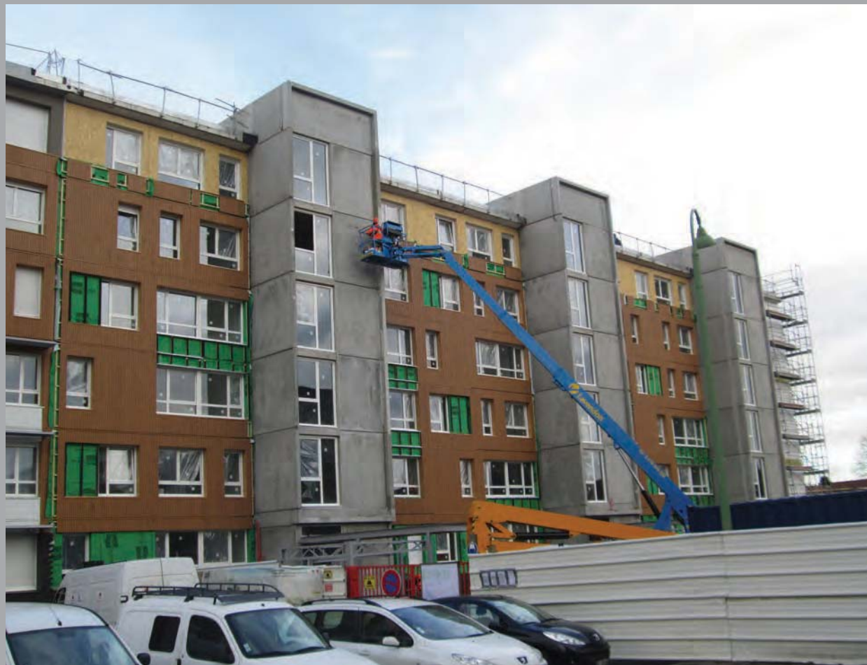
Vue sur la troisième tranche travaux depuis l'avenue J.F Kennedy
