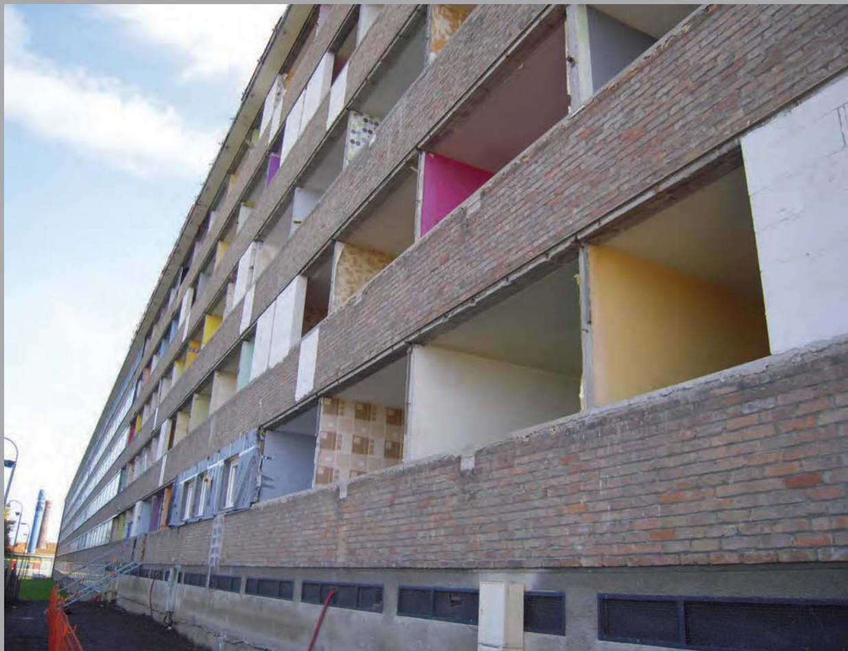
Première tranche travaux : Façade sur rue J.B Corot
