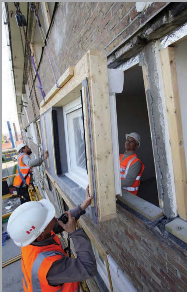
Pose des façades préfabriquées bois sur rue J.B Corot
