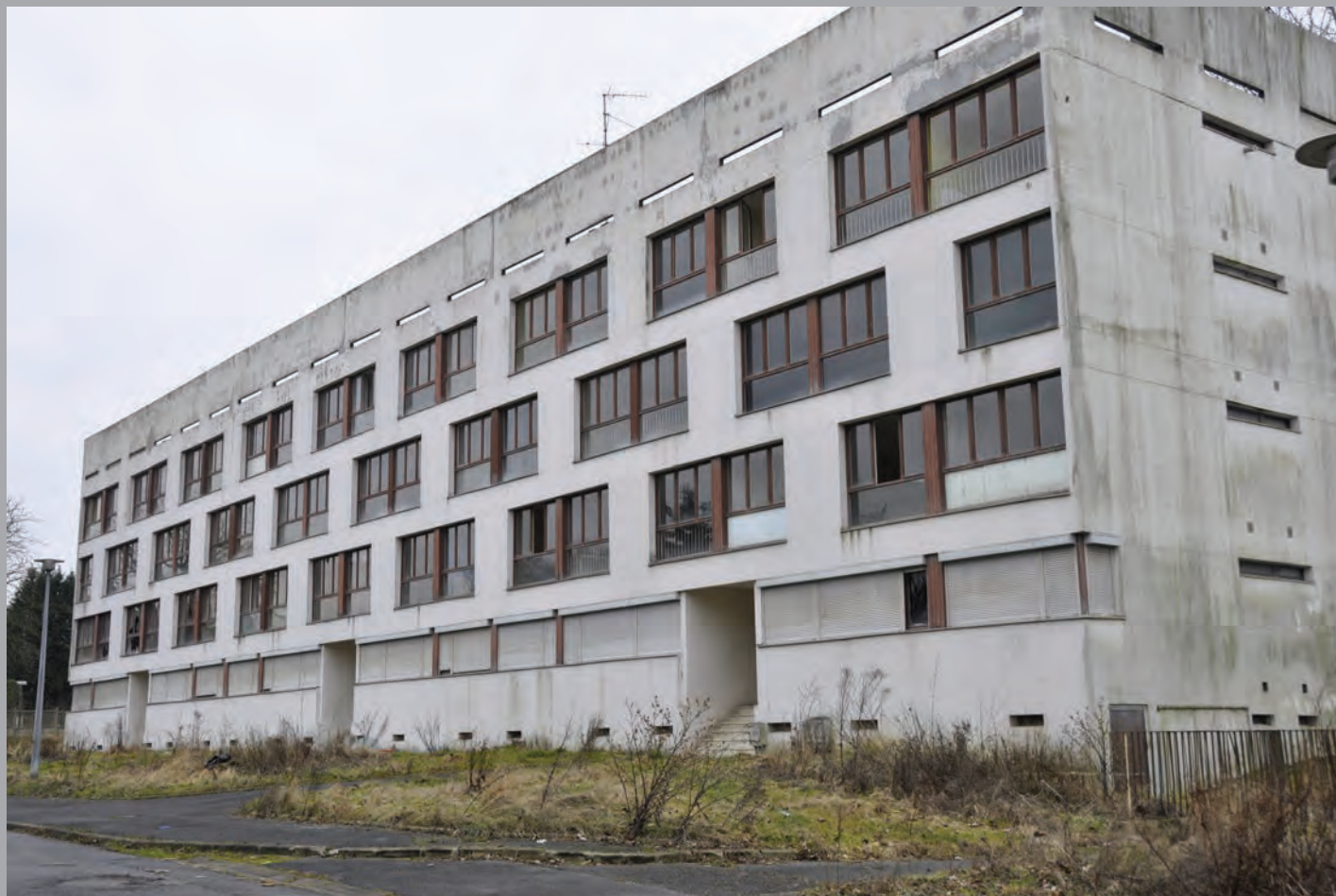
Vues de la façade sur rue
