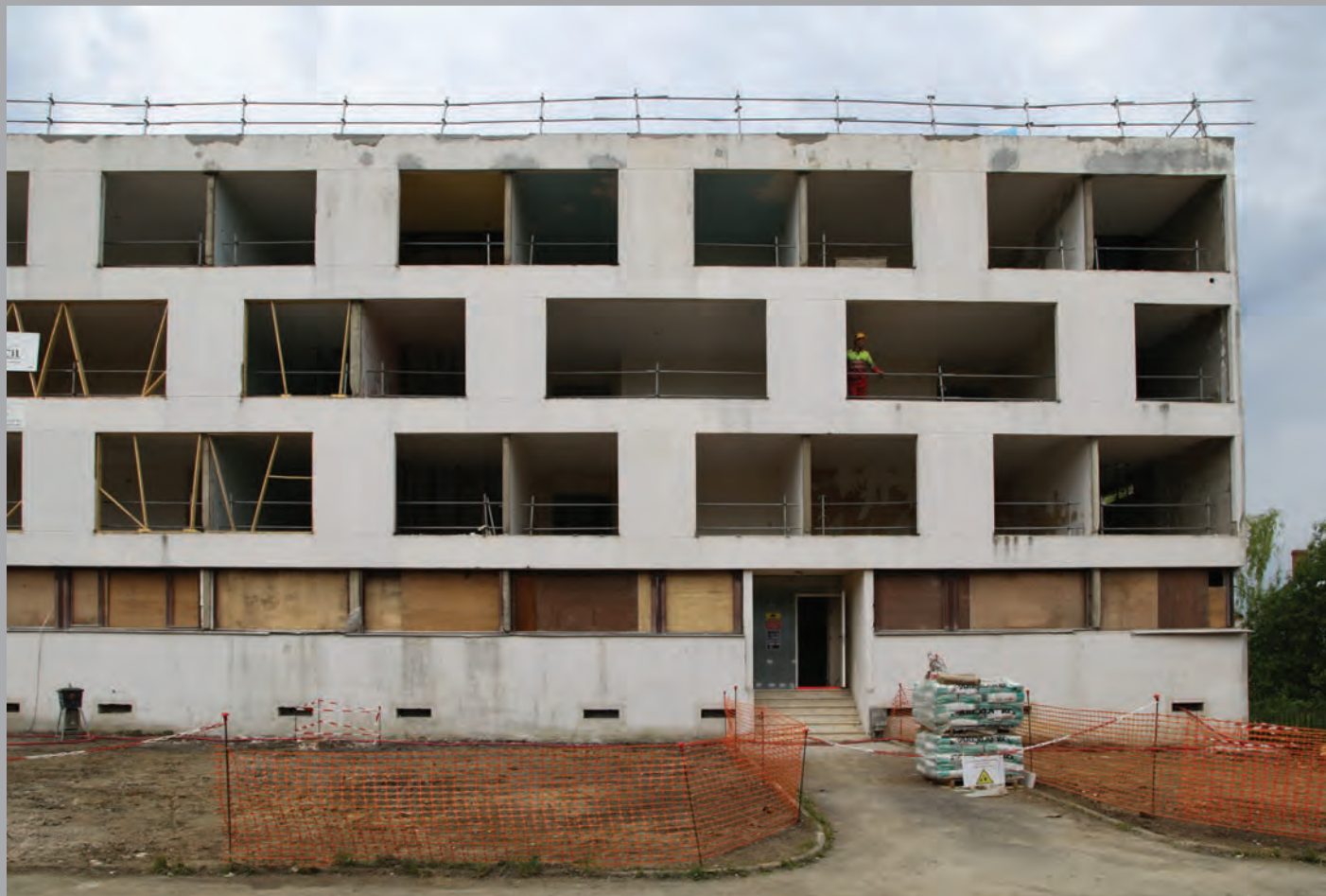
Dépose des menuiseries existantes
