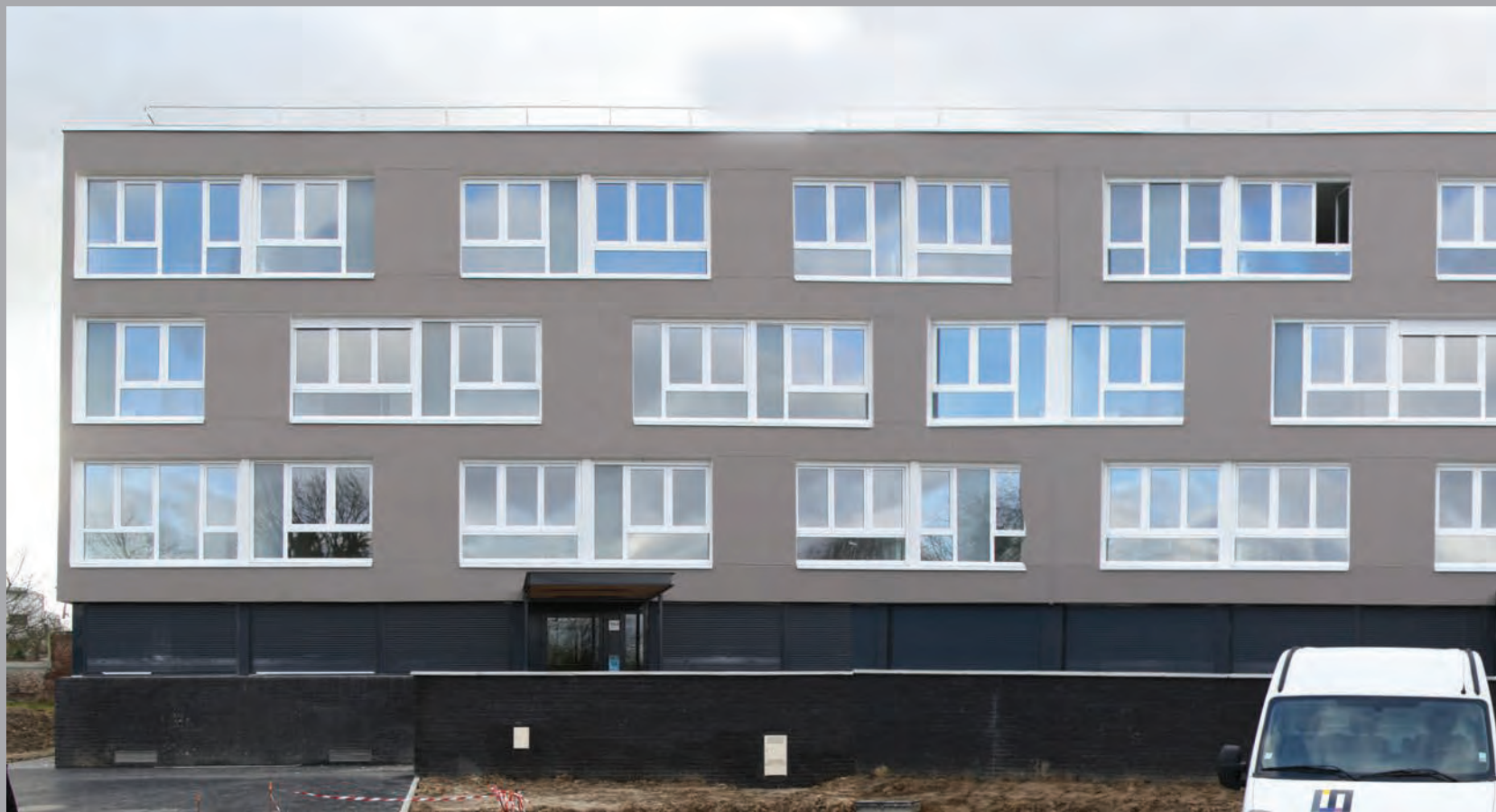
Vue panoramique de la façade sur rue en chantier
