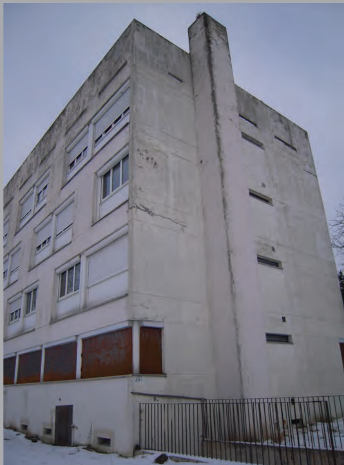
Pignon visible depuis la rue
