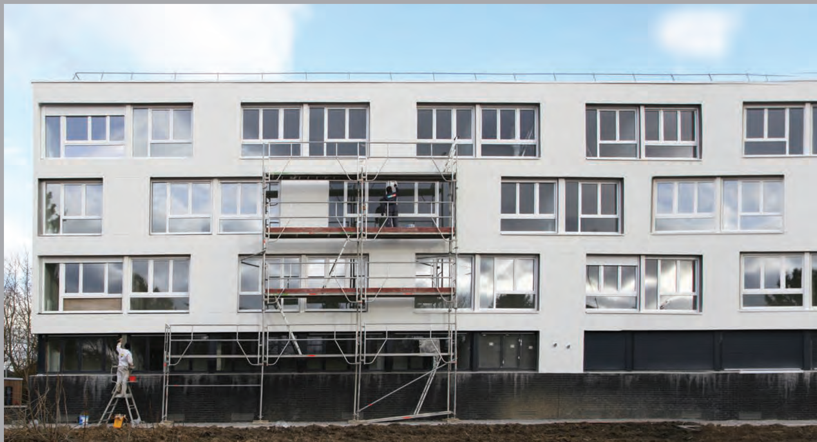
Vue panoramique de la façade sur jardin en chantier
