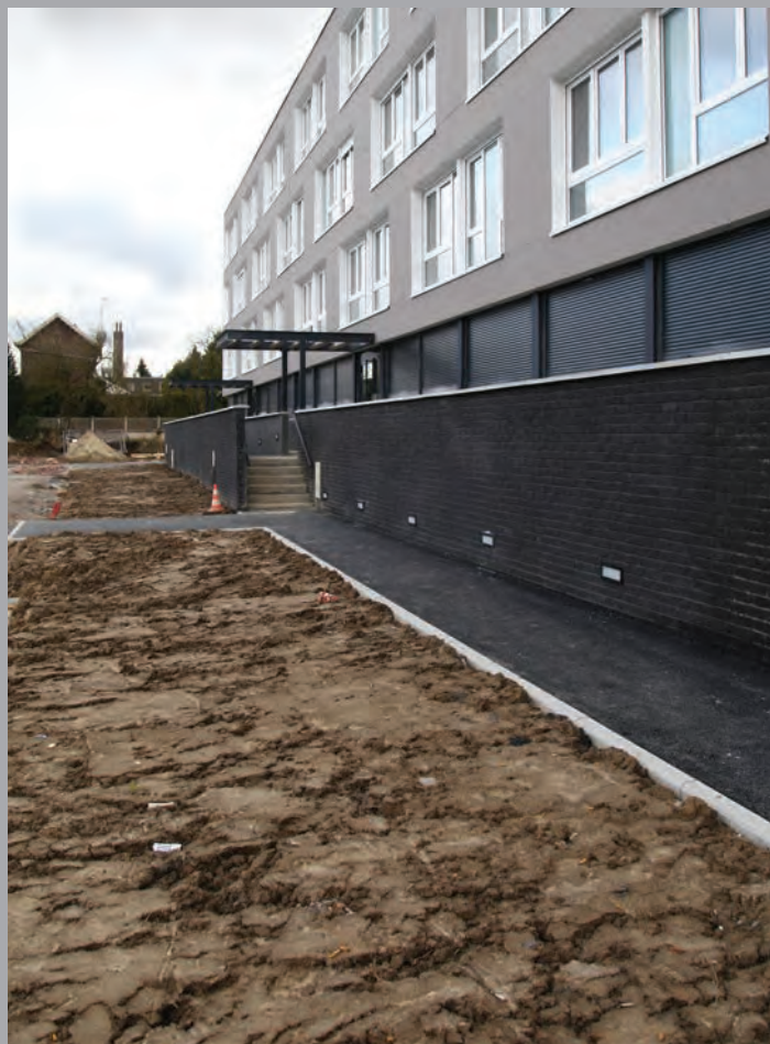
Réalisation de la rampe PMR et des entrées
