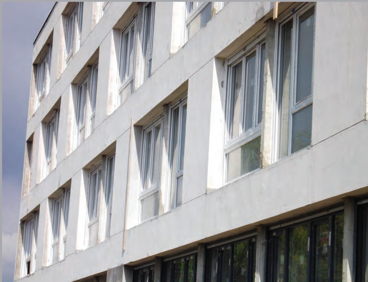
Pose des menuiseries, vue de la façade sur rue
