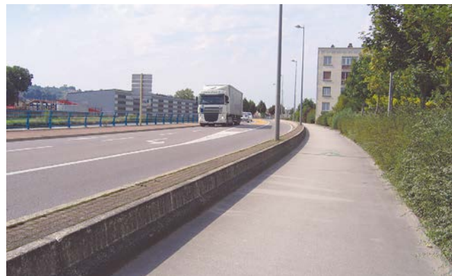
Source : CETE de l'Est
