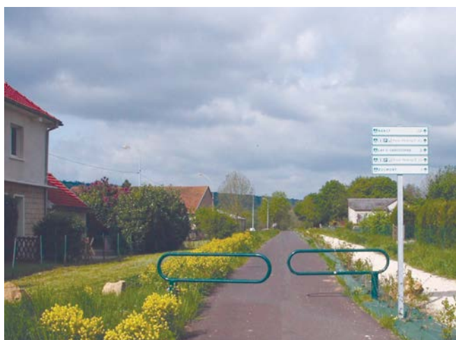
Source : CETE de l'Est
