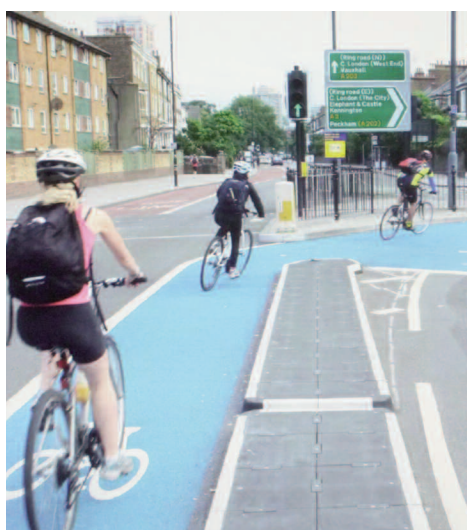
Londres : revêtement peint en bleu maintenant une bonne adhérence, jalonnement spécifique Source : Cerema Est
