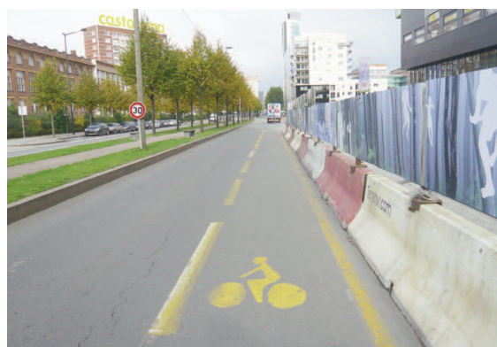
Rétablissement de la bande cyclable pendant les travaux
