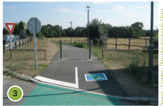
Voie verte le long de la RD
