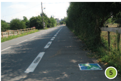
Voie verte le long de la RD
