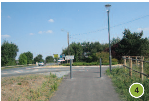
Voie verte le long de la RD
