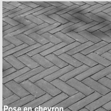
Pose en chevron
