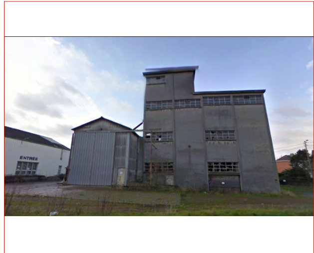
Usine désaffectée - Bailleul
