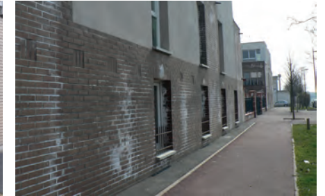
Relation visuelle directe de l'espace public sur l'espace privé - Hautmont Bois du Quesnoy
