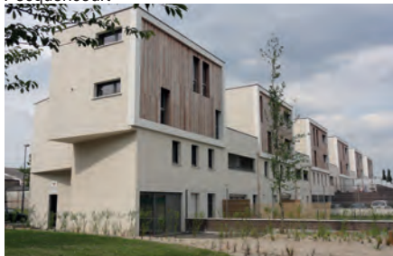
Volume simple et rythmé en attique avec enduit et remplissage bois - Roubaix Quai de Marseille
