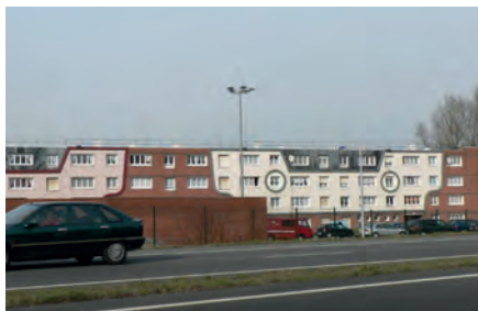
Bâtiment R+3 construit en brique et dévalorisé lors de sa réhabilitation. Il va très mal vieillir. Grande-Synthe (hors PNRU)
