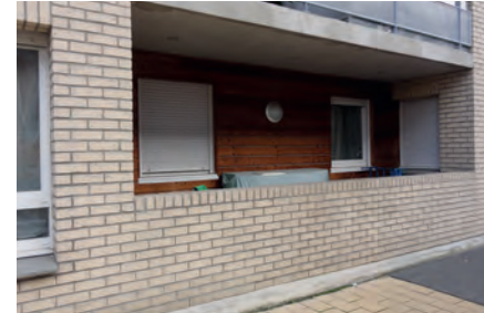
Relation visuelle directe de l'espace public sur l'espace privé - Dunkerque Jeu de Mail
