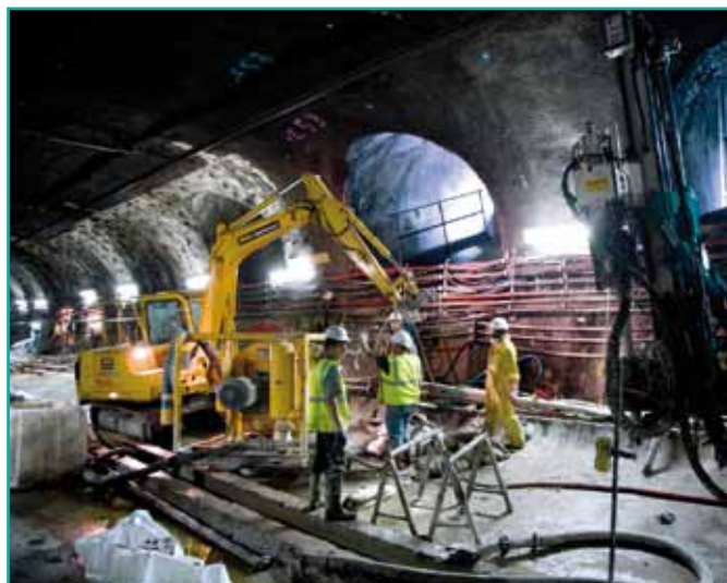
Un chantier du RER (crédit RFF, Source Travaux-castor.fr)
