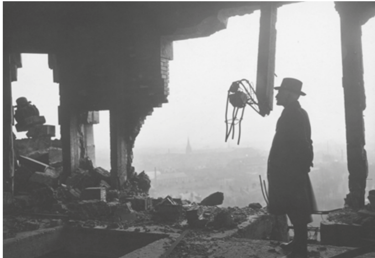
Effets d'une bombe dans la partie haute du nouvel Hôtel-de-Ville de Calais, Dufour, 1918
