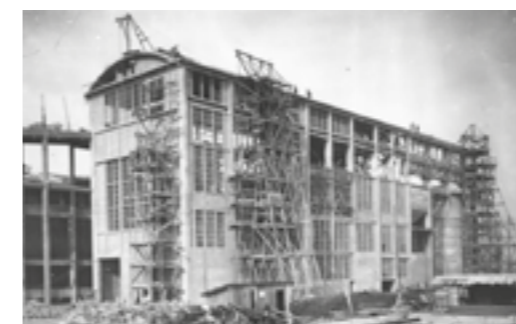
Construction de l'usine de Chantereine en 1922 avec les dommages de guerre Huttin © Archives Saint-Gobain
