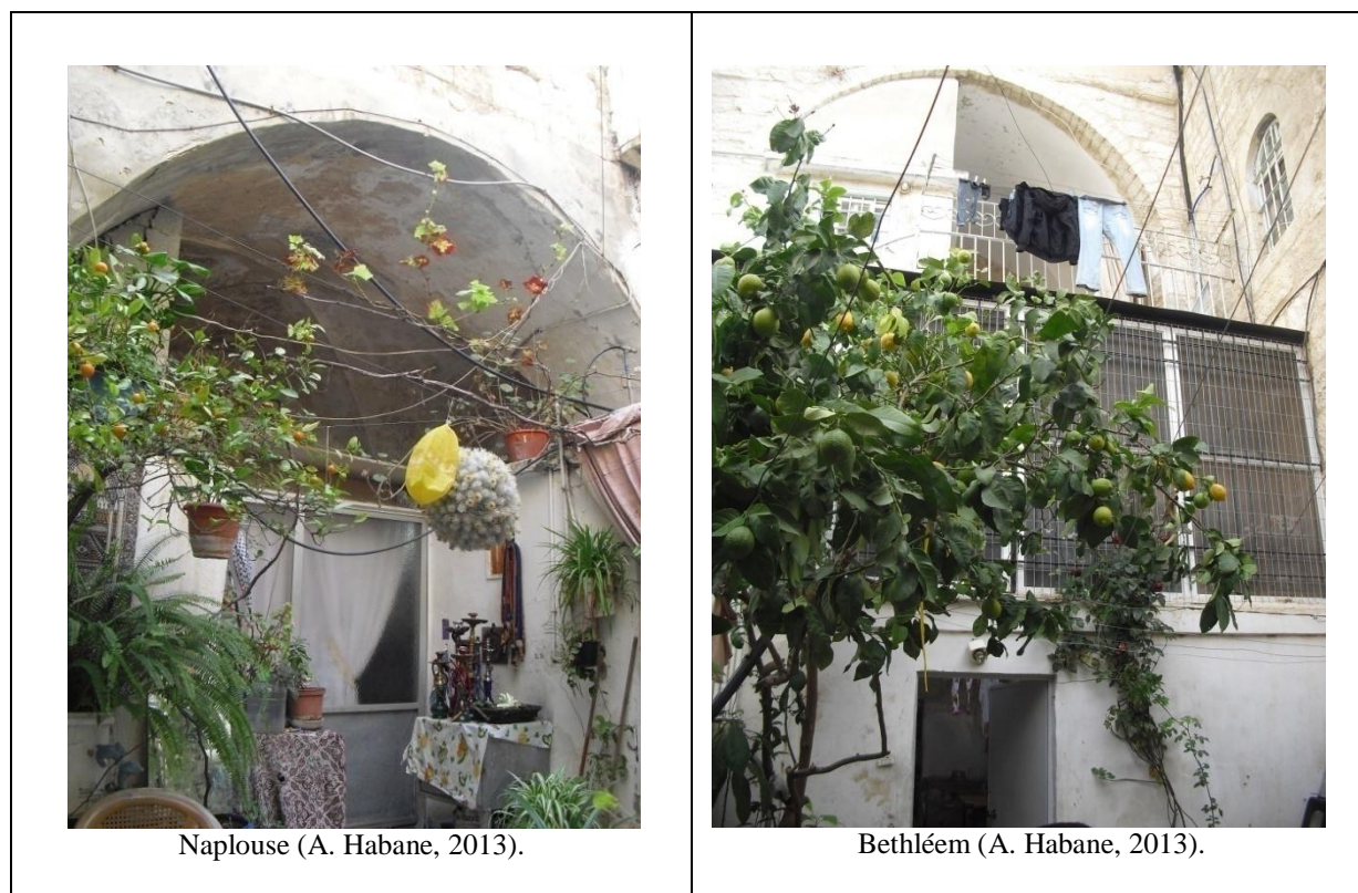
Figure 57 : Fermeture partielle de l'iwan pour l'aménagement d'une pièce supplémentaire
