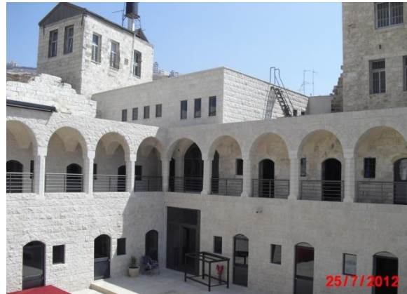
Le caravansérail de Khan Al-Wakala après la rénovation. Source : A. Habane, juillet 2012.
