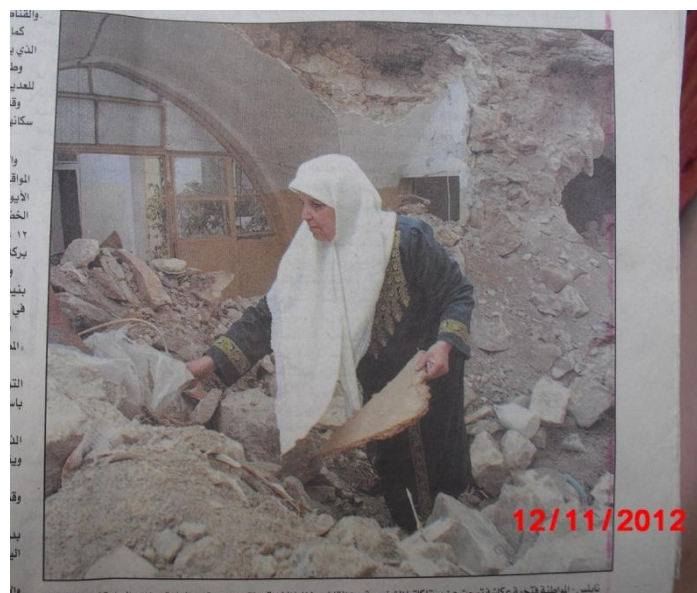
Figure 36 : Destruction d'un bâtiment historique dans la vieille ville de Naplouse
