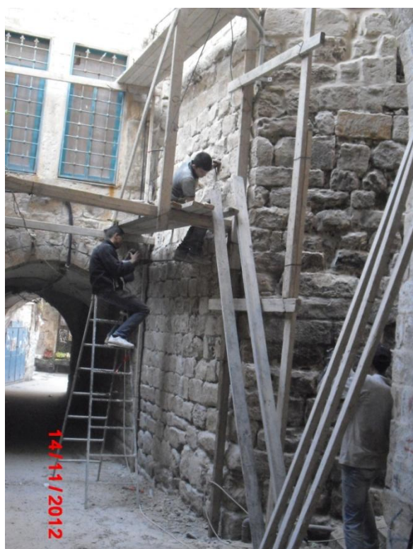
Façade d'une ruelle en cours de restauration (A. Habane, novembre 2012)
