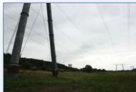
Rupture d'échelle entre le hameau de Benne, les lignes HT et la centrale.
