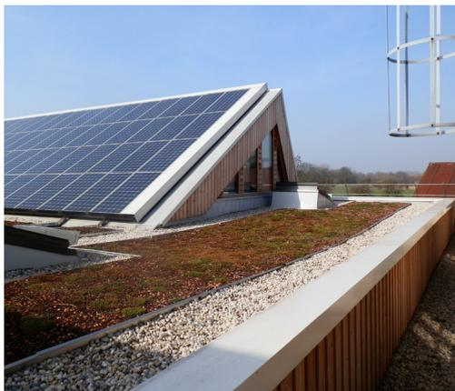
Le projet a constitué en un dégagement de la totalité des charpentes et toitures des 3 bâtiments et la restructuration de charpentes métalliques avec un nouveau de profil à sheds laissant entre chaque shed une large surface de toiture terrasse dont le procédé de végétalisation permet une isolation efficace du bâtiment et la pratique de la terrasse.
