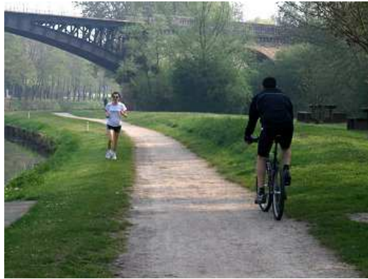
Figure 41 : Le canal d'Orléans à Vitry-aux-Loges
