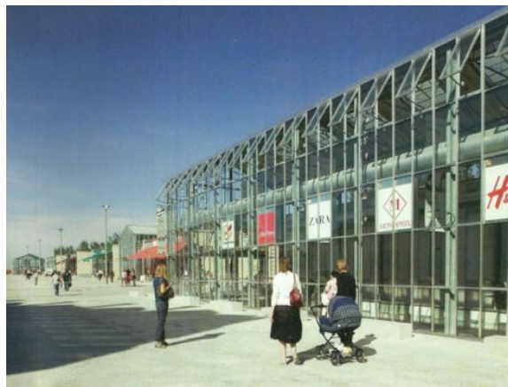
1 : Vue sur le parc situé sur la toiture du centre commercial Vache Noire.
