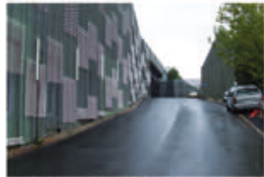
3 : Accès à la zone de livraison
