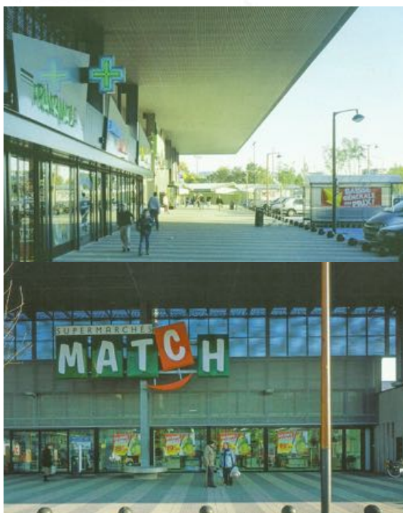
Source : Maillard, Carol (2006). 25 Centres commerciaux . Paris : Le Moniteur, p. 113-115. Centre commercial dans la banlieue de Reims.
