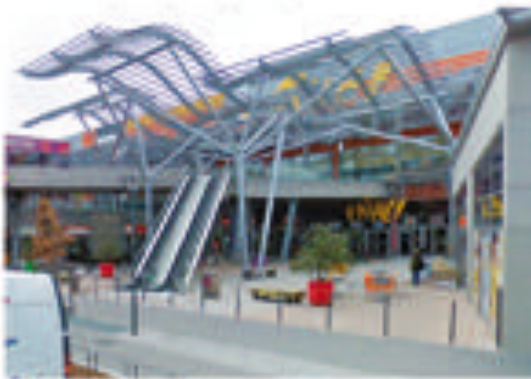
3 : Entrée par la place centrale
