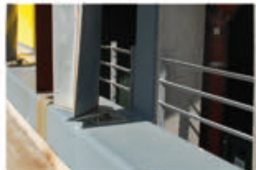
4 : Zoom sur le muret servant d'assise
