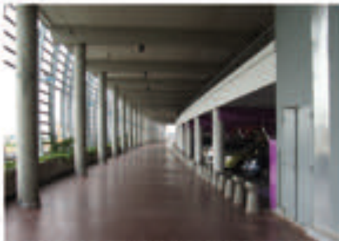
1 : Couloir à l'étage reliant le parking des commerces
