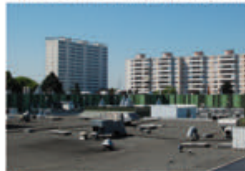
3 : Toiture en asphalte avec la toiture végétalisée au 2ème plan.
