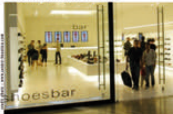
4 : Paroi totalement vitrée - présence d'un seal adhésif
