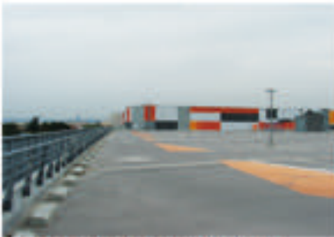
1 : Parking en toiture du bâtiment de 3 étages.
