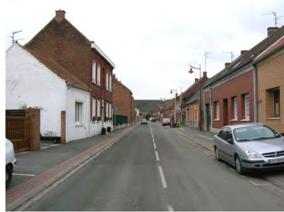
Un traitement d'une voirie principale en traversée de bourg, associant sobriété des matériaux et effacement de réseau (Vred)
