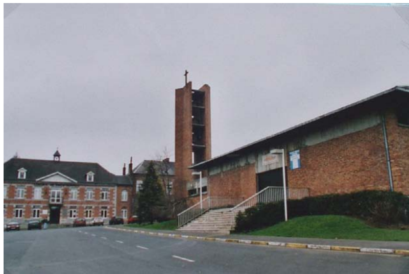
fig. 3 Vue extérieure, façade principale (photo AD Cambrai Classeur)
