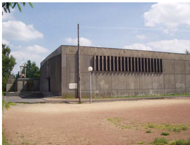
fig.2 Vue extérieure, façade latérale
