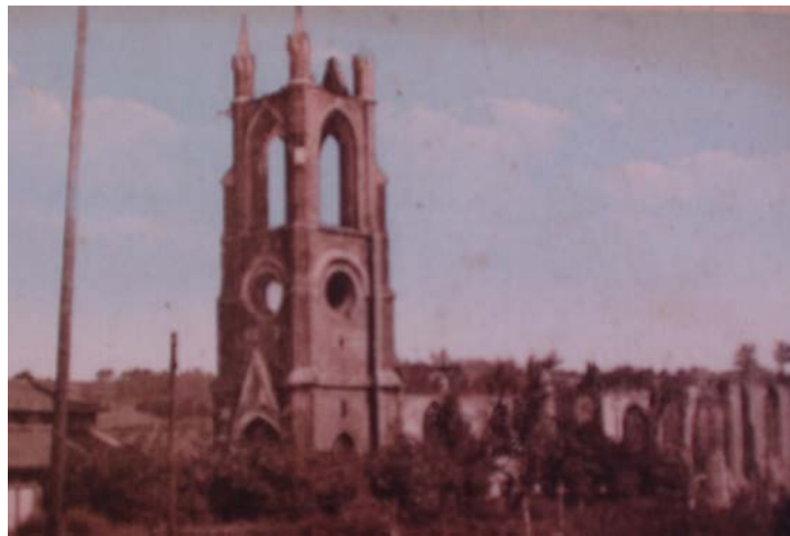
fig. 5 Ruines de l'église (photo AHDL 32 N 39)
