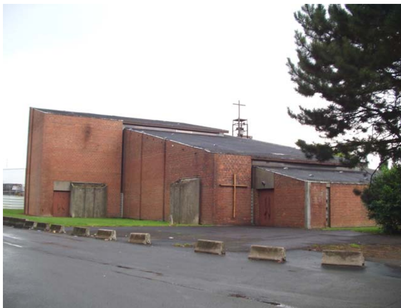
Fig.1 Vue extérieure, entrée
