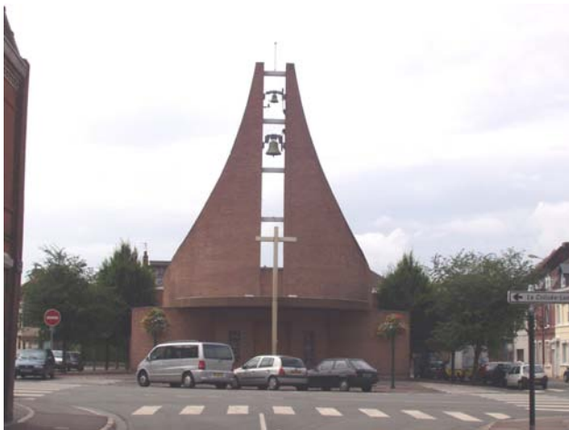
fig.1 Vue extérieure, entrée
