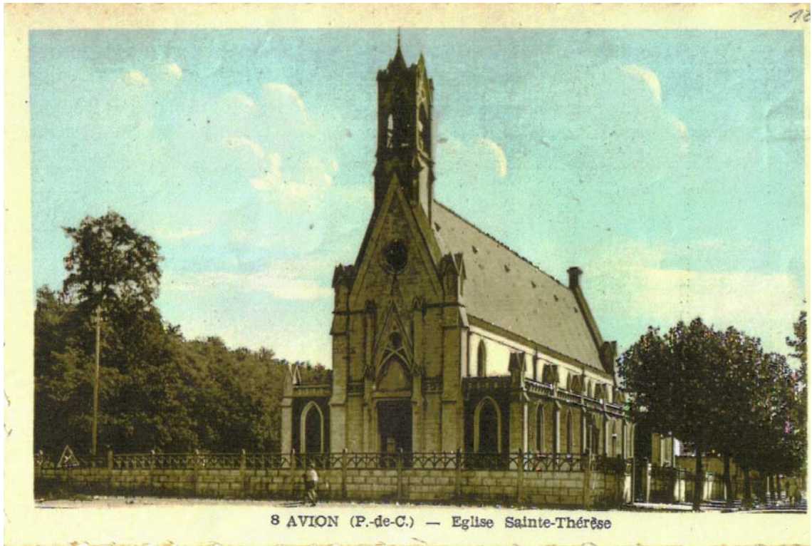
fig. 2 Ancienne église (photo AM Avion)
