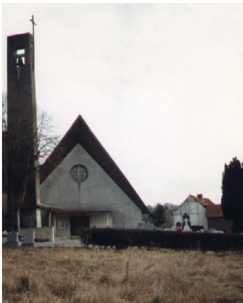
fig. 1 Vue extérieure façade
