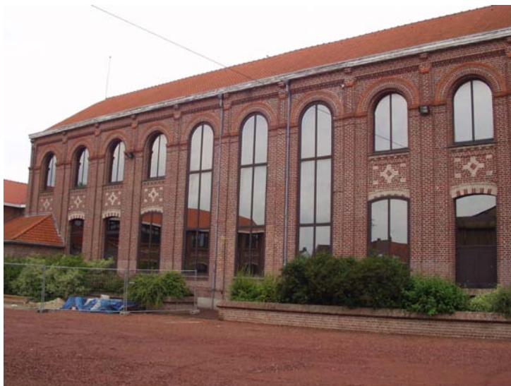
fig.3 Vue extérieure sur cour
