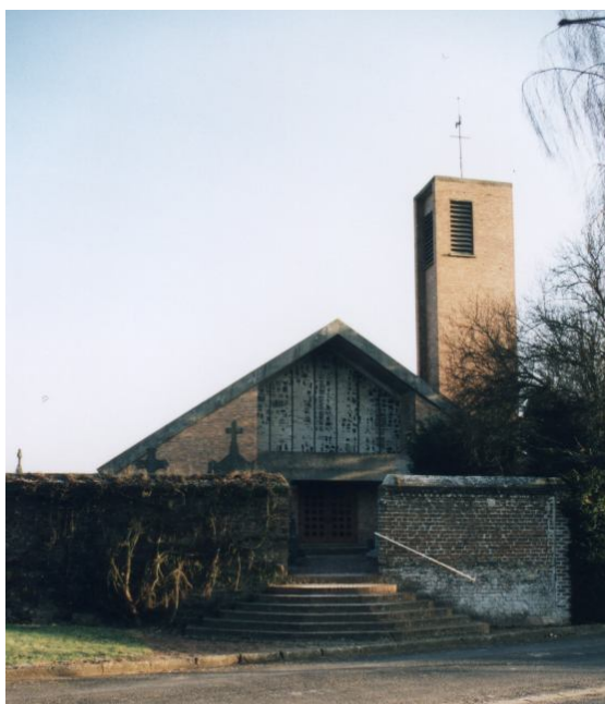
fig. 3 Vue extérieure (photo CDAS)
