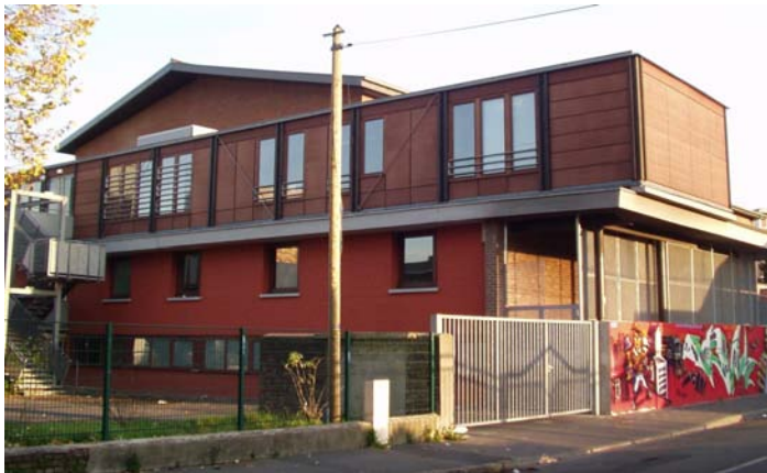
fig. 5 Vue extérieure, adjonction de bureaux pour la maison de quartier
