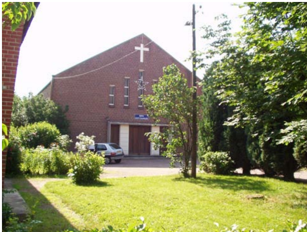
fig. 1 Vue extérieure sur la façade
