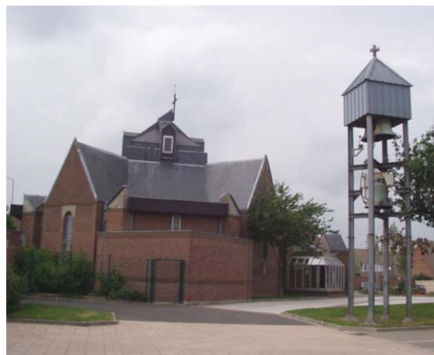
fig.2 Vue extérieure, façade Nord
