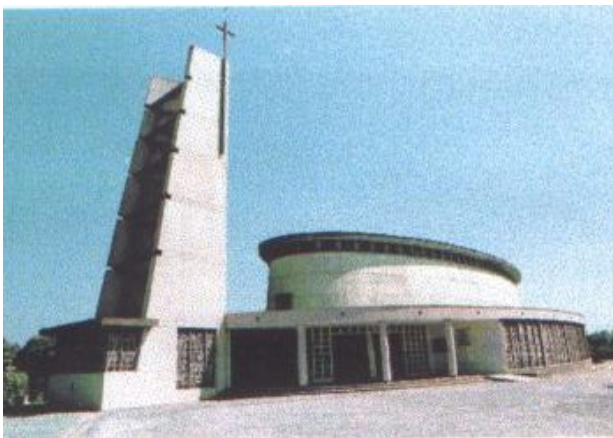
fig.1 Vue extérieure (AM Marck)
