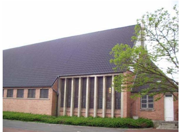
fig. 4 Vue extérieure sur le chevet
