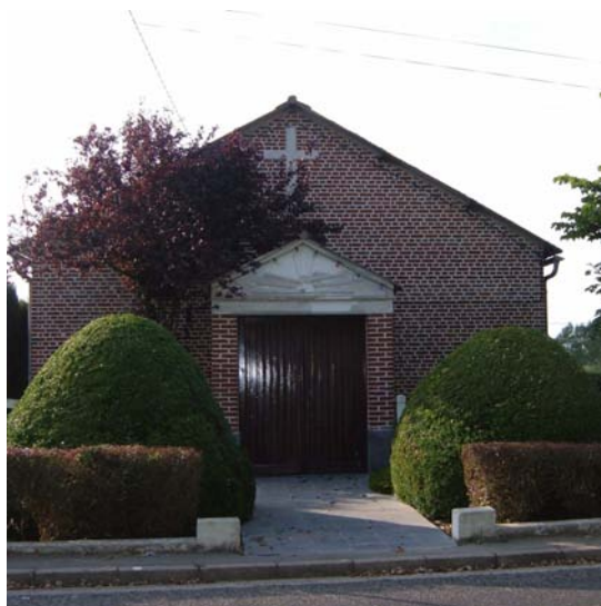
fig.1 Vue extérieure façade
