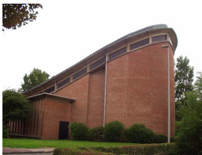
fig. 2 Vue extérieure sur le chevet
