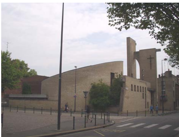
fig.1 Vue extérieure sur la rue Jean Macé
