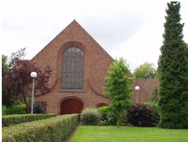
fig.3 Vue extérieure, entrée
