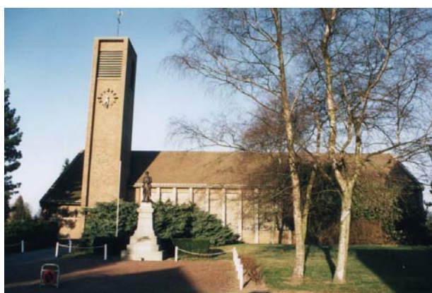
fig. 1 Vue extérieure (photo CDAS)
