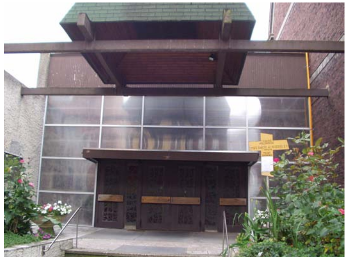
fig.2 Vue extérieure, entrée
