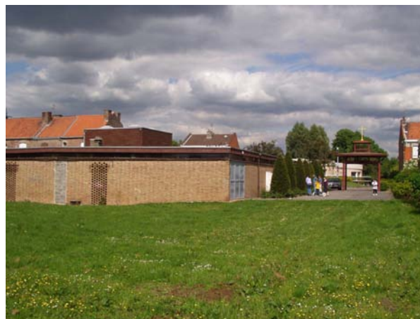
fig. 2 Vue extérieure sur parvis
