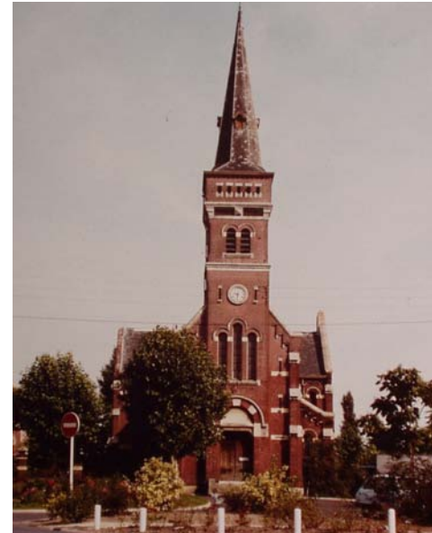
fig.5 Ancienne église (photo AD Cambrai Églises neuves)
