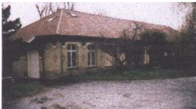
fig. 1 Vue extérieure (Photo CDAS)
