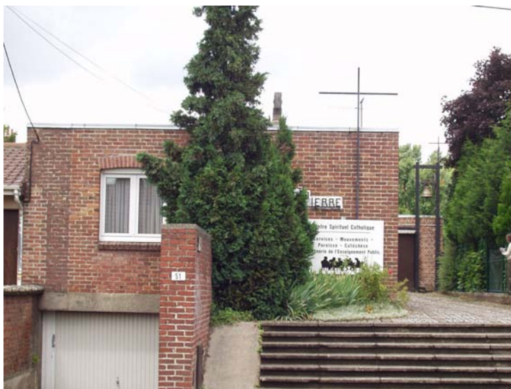
fig.2 Vue extérieure, façade
