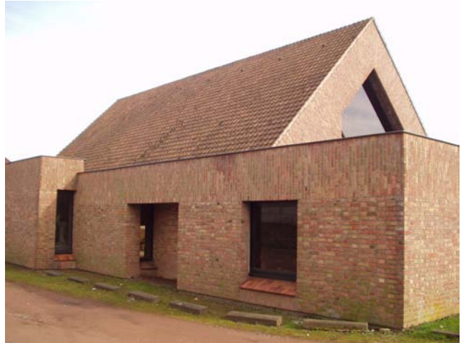
fig.4 Vue extérieure, façade postérieure
