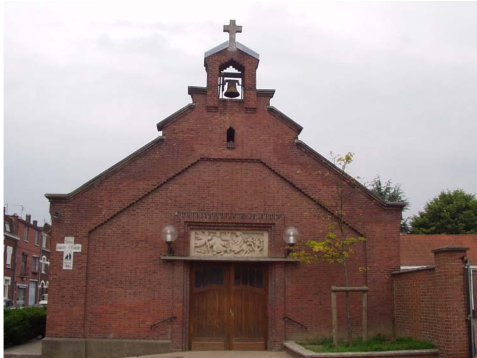
fig.2 Vue extérieure, façade
