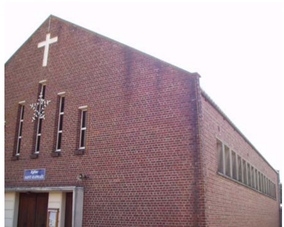
fig.2 Vue extérieure angle sud-ouest
