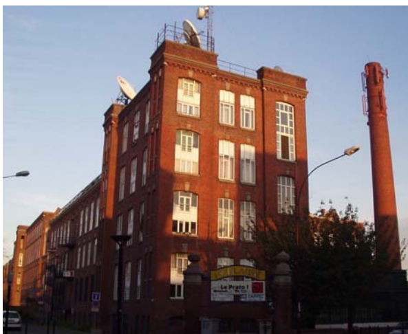
fig.1 Vue extérieure, l'usine Le Blan reconvertie
