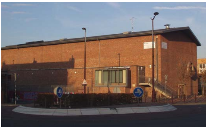
fig.1 Vue extérieure, façade latérale
