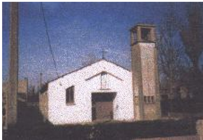
fig.1 Vue extérieure (photo CDAS)
