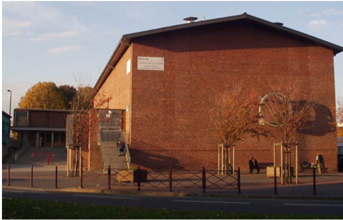
fig. 3 Vue extérieure, façade sur le boulevard
