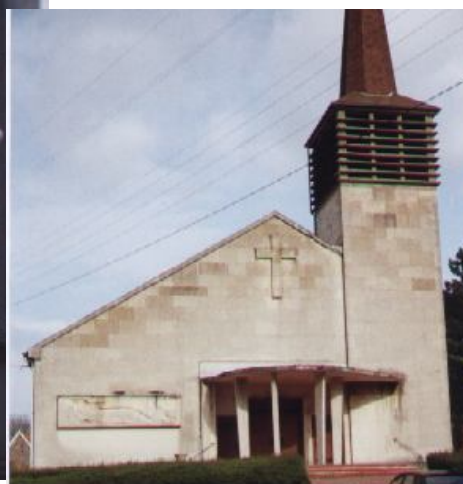
fig. 2 Vue extérieure, façade
