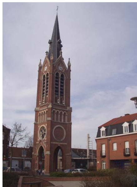
fig. 2 Vue extérieure, ancien clocher
