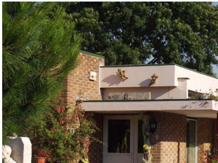
fig. 4 Vue de l'entrée : la croix de l'ancienne église est toujours visible
