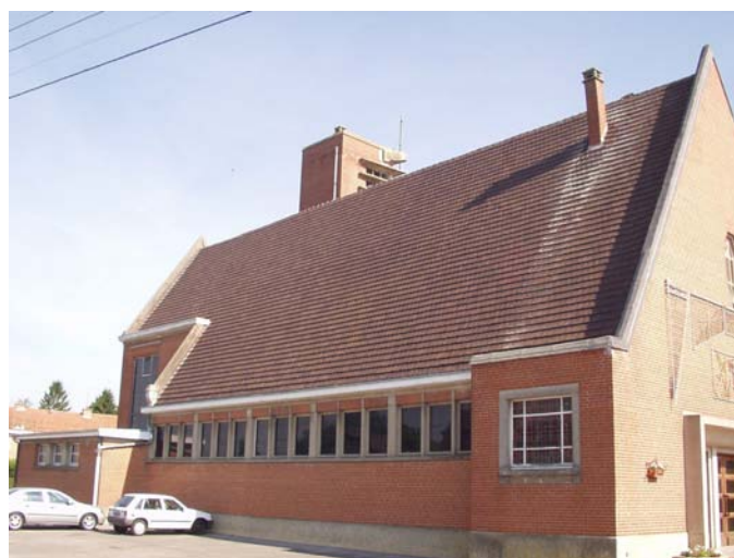
fig.2 Vue extérieure, façade latérale
