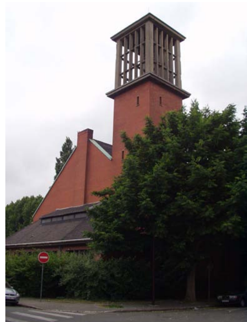
fig. 2 Vue extérieure, façade postérieure
