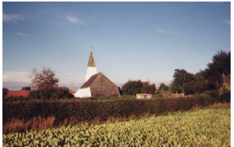
fig. 2 Vue extérieure sur le chevet
