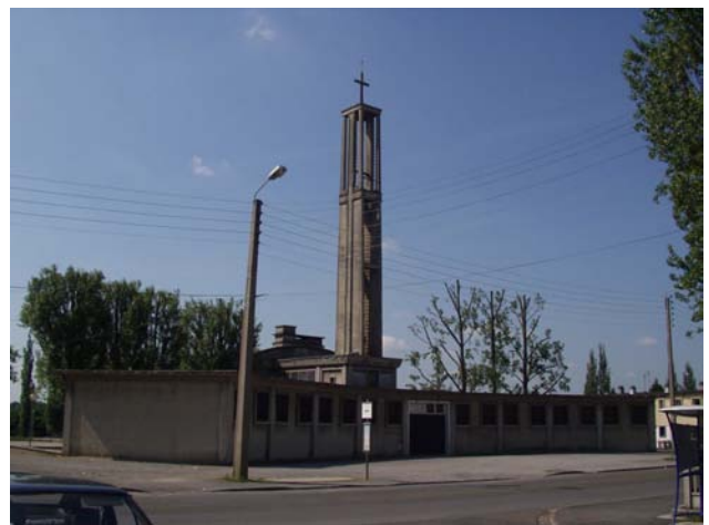
fig. 2 Vue extérieure, façade postérieure
