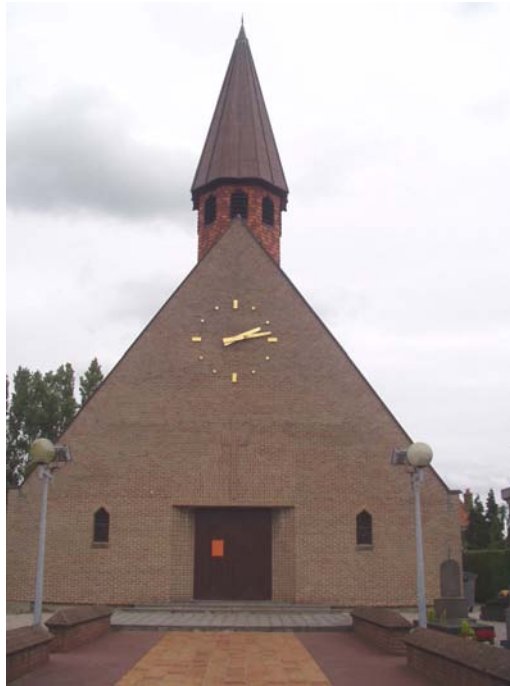
fig.2 Vue extérieure, façade
