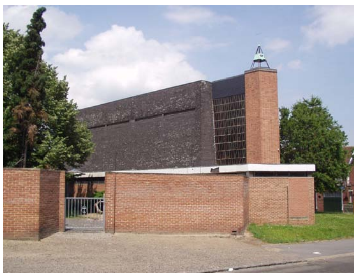
fig.1 Vue extérieure, entrée
