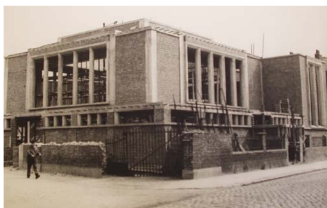
fig.4 L'église en chantier (photo AHDL 32 N 201)
