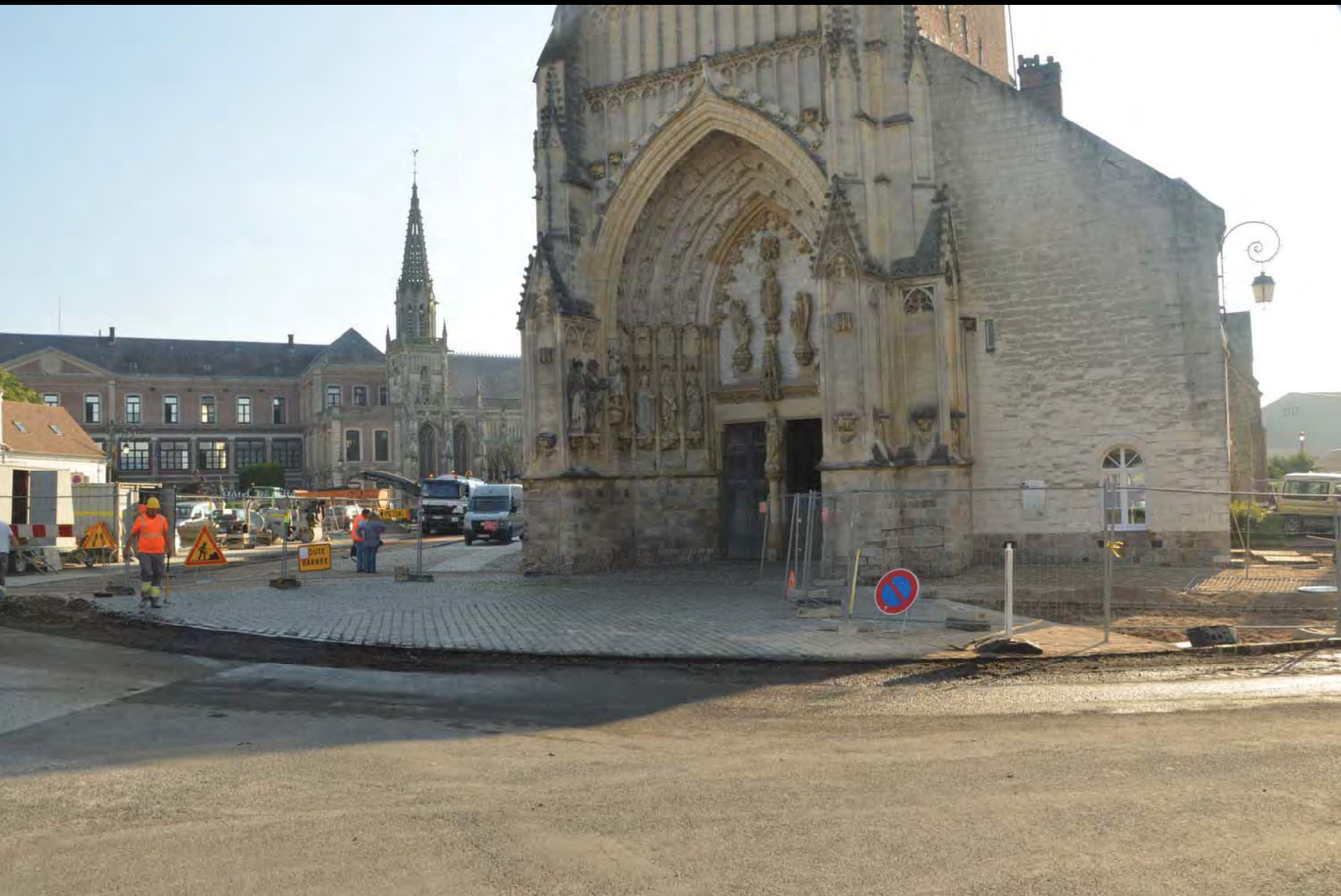
Abords de l'église – chantier
