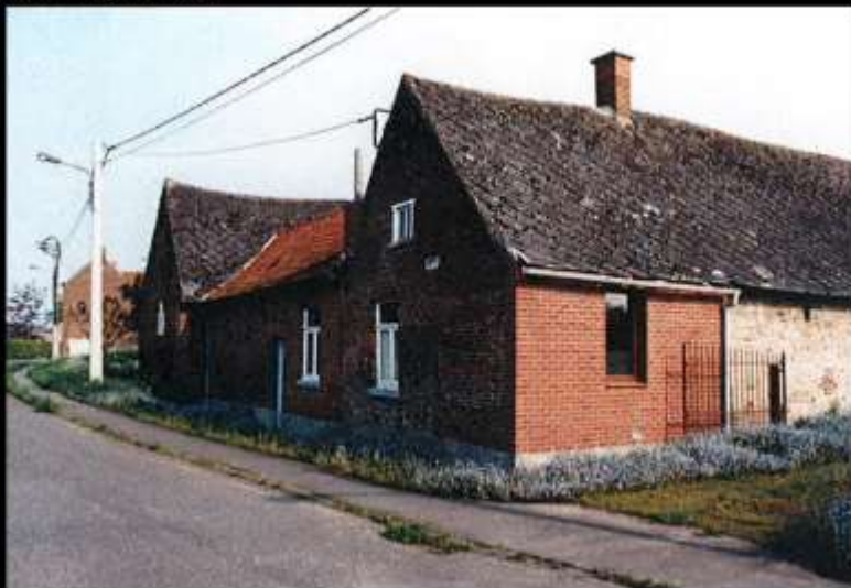
vue 1 - façade nord
