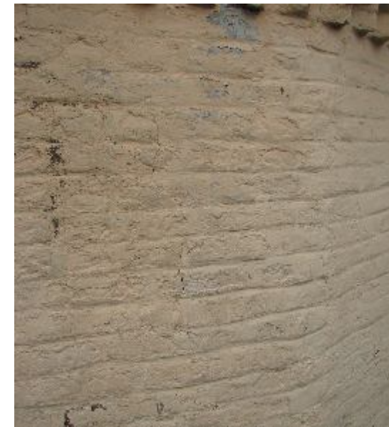
Vue sur parement extérieur
