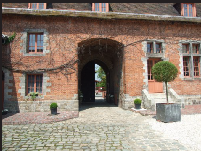
Le passage sous porche nous permet de pénétrer dans la grande cour carrée
