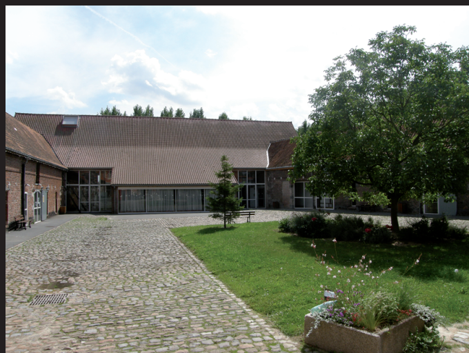
La cour intérieure pentagonale, conserve sa fonction de distribution vers les différents lieux
