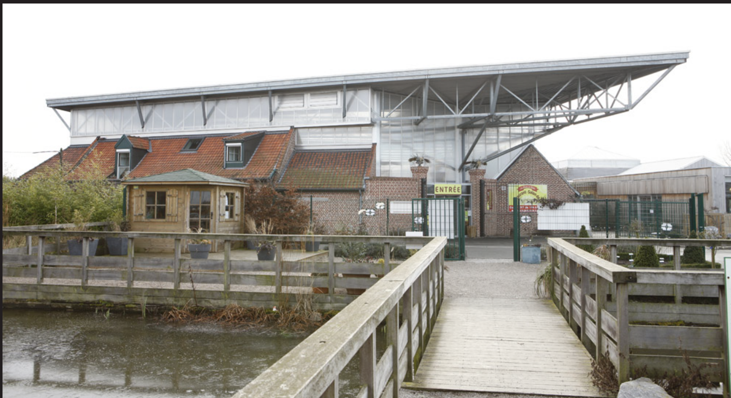
Les volumes originaux de la ferme ont été conservés et la cour a été couverte d'une verrière surélevée.
