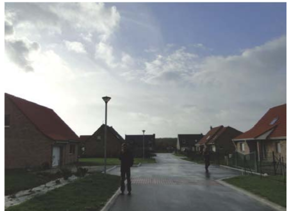
Lottissement récemment réalisé
