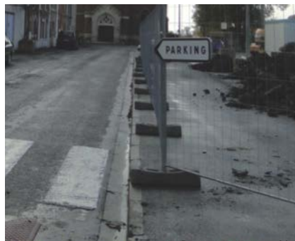
Centre - ville Construction de la nouvelle mairie
